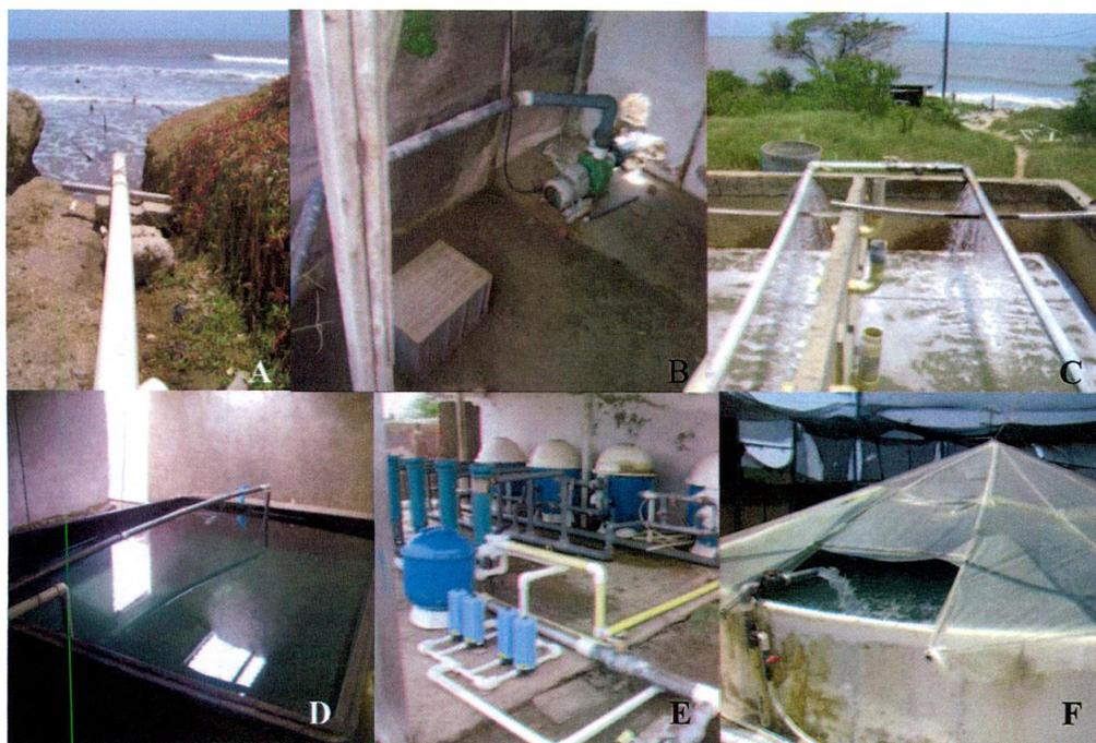
**Figura 13.** Toma y proceso de filtración del agua de mar en HIDROCULTIVOS DE LA COSTA LTDA. Toma (A); Puesto de bombeo (B); Filtro de arena (C); Tanque de recepción del agua bombeada (D); Sistema de filtración (E) y Reservorios de agua de mar filtrada y clorada (F)
