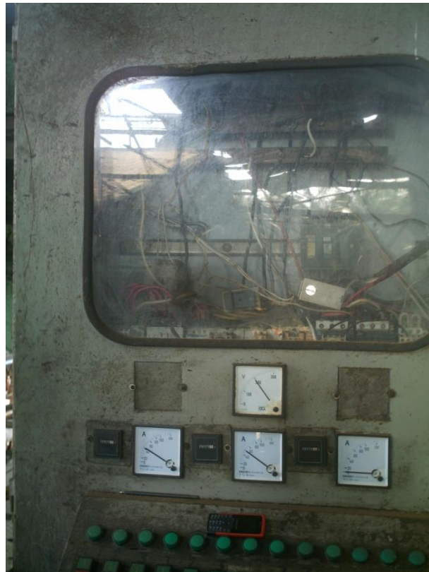
Imagen 11 Fotografía del Tableros de Control Digestores y Prensas (Parte Interna)
