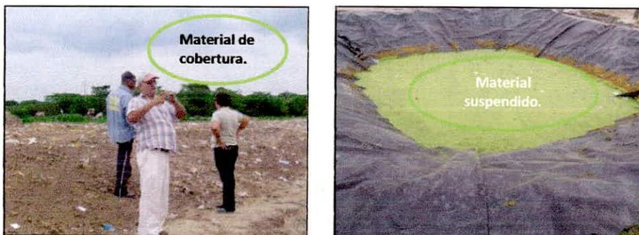
Foto 7: celda de tipo combinado y piscina de lixiviados
