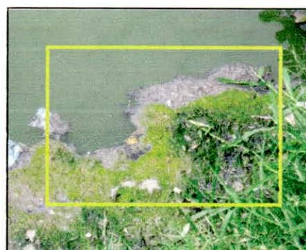
Foto 10: diques perimetrales erosionados y material flotante en laguna de oxidación
