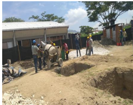
Imagen 3. Construcción Edificio Modular
