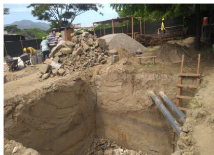
Imagen 5. Construcción Edificio Modular
