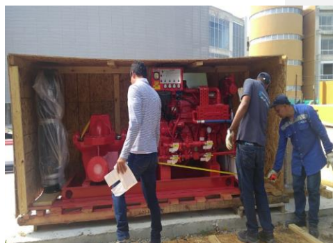
Imagen 12. Obras de ampliación y modernización redes hidrosanitarias
