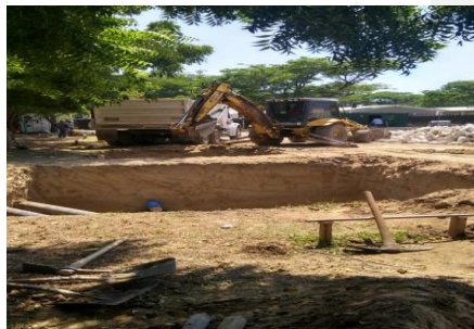
Imagen 16. Construcción Edificio Modular
