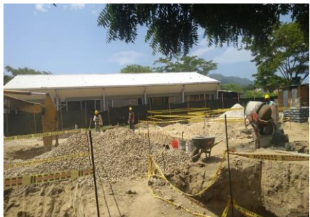
Imagen 15. Construcción Edificio Modular
