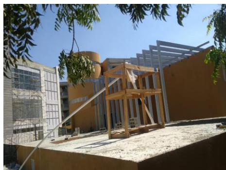
Imagen 11. Obras de ampliación y modernización redes hidrosanitarias
