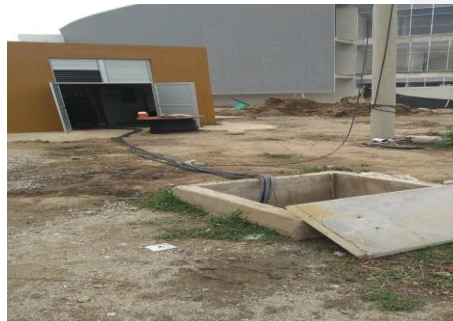
Imagen 8. Obras de ampliación y modernización redes eléctricas de baja y
