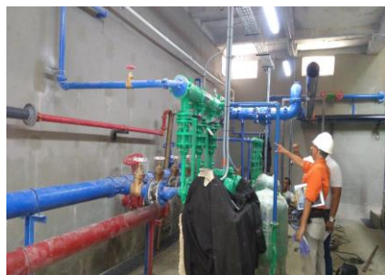
Imagen 17. Obras de ampliación y modernización redes hidrosanitarias
