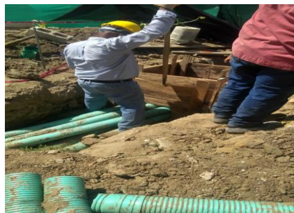
Imagen 9. Obras de ampliación y modernización redes eléctricas de baja y
