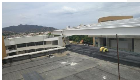
Imagen 10. Obras de terminación Nuevo Edificio de Aulas Rio Magdalena
