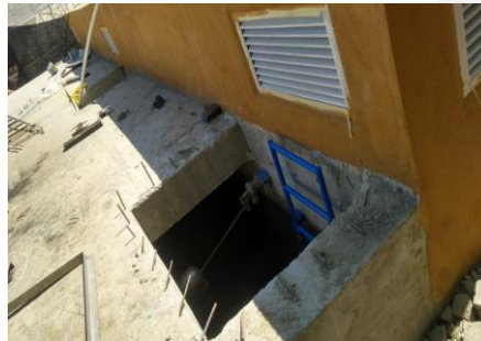
Imagen 14. Obras de ampliación y modernización redes hidrosanitarias
