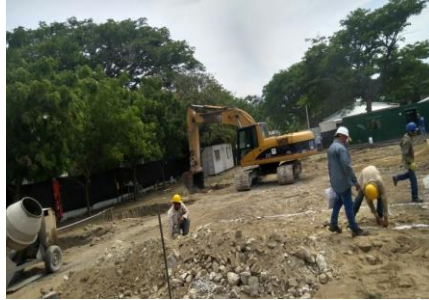
Imagen 2. Construcción Edificio Modular
