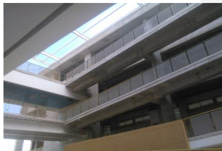
Imagen 18. Obras de terminación Nuevo Edificio de Aulas Rio Magdalena
