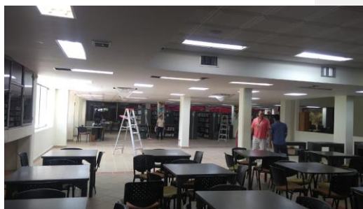
Imagen 20. Obras de mantenimiento Biblioteca
