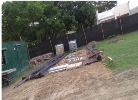
Imagen 13. Construcción Edificio Modular
