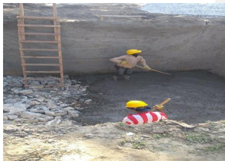
Imagen 6. Construcción Edificio Modular
