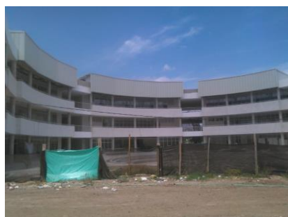
Imagen 19. Construcción Centro de Bienestar Universitario
