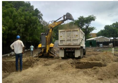
Imagen 4. Construcción Edificio Modular
