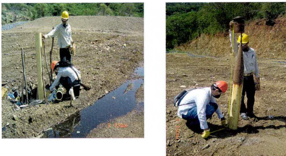
Figura 9. Medición de alturas y diámetros de chimeneas en campo
