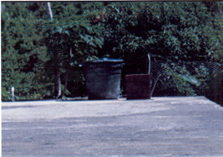
Foto 14 Tanque de 500l utilizado para la desinfección
