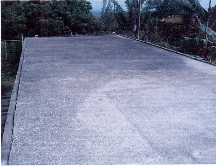
Foto 15 Tanque de almacenamiento capacidad 200m 3
