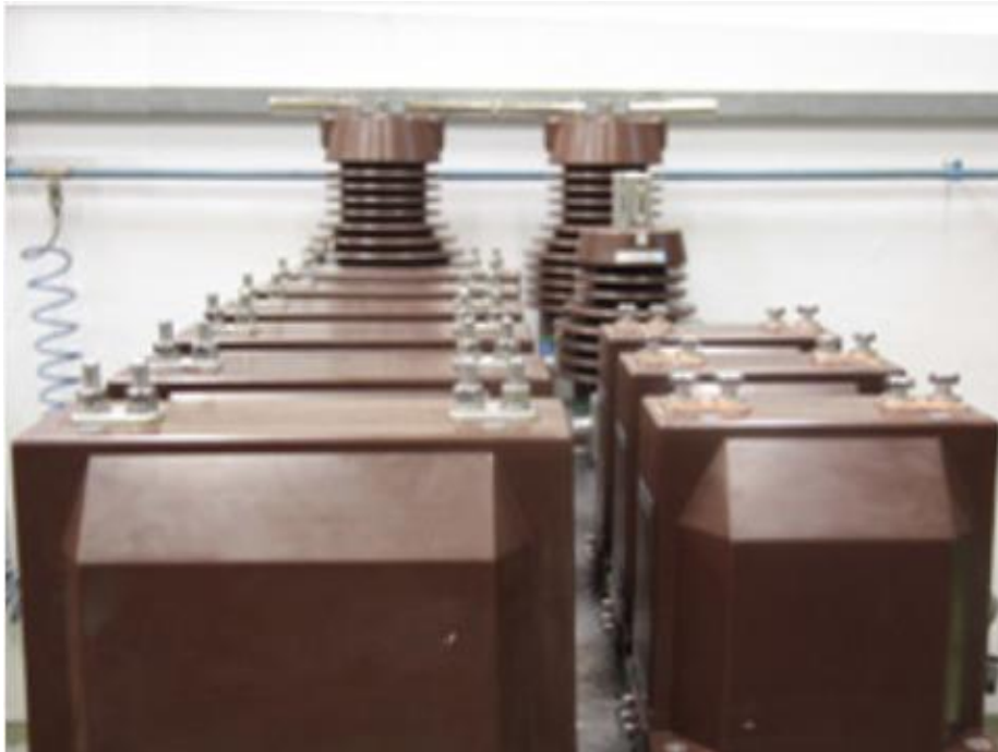
Slika 9. Strujni epoksidni transformator INA[1]
