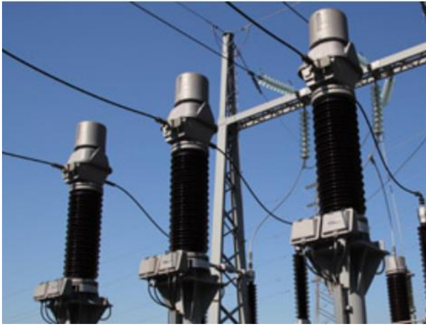
Slika 7. Kombinirani mjerni transformator VAU[1]
