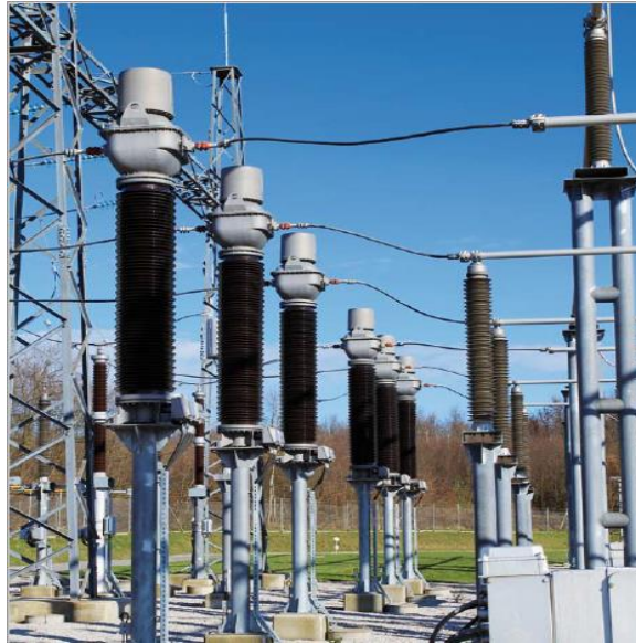
Slika 1. Kombinirani mjerni transformator VAU[1]
