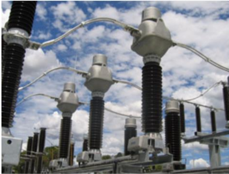
Slika 3. Strujni mjerni transformator AGU[1]
