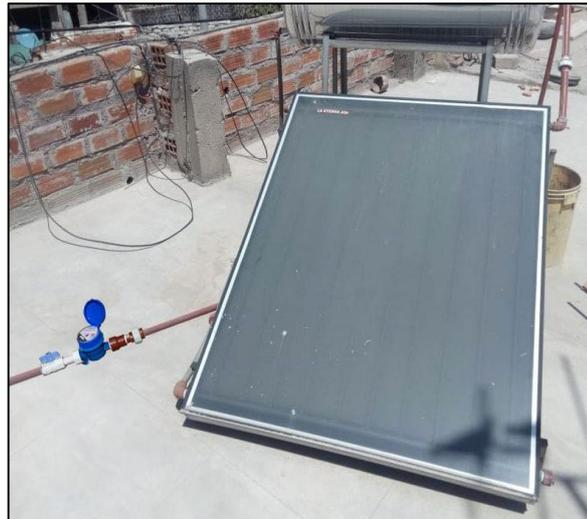
Figura N° 54. Verificación de no existencia de fugas.
