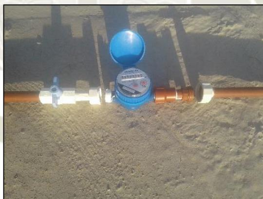
Figura N° 53. Roscado y ajuste de accesorios.
