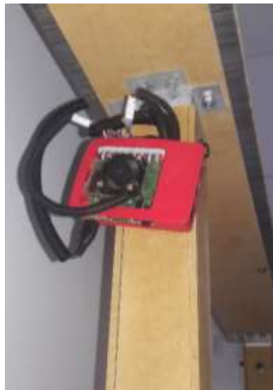
Figura 4.6 Protección de los cables de conexión de los sensores
