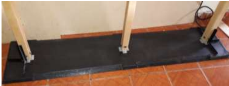
Figura 4.3 Base de la estructura
