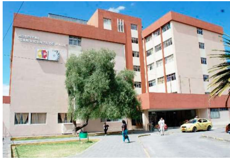
Figura 1. Hospital San Vicente de Paúl - Ibarra
