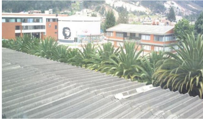
Figura 19: Tejado edificio de aulas UPTC Seccional Sogamoso
