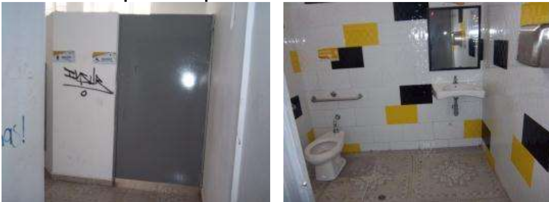
Foto 7. Baños para discapacitados en el edificio central
