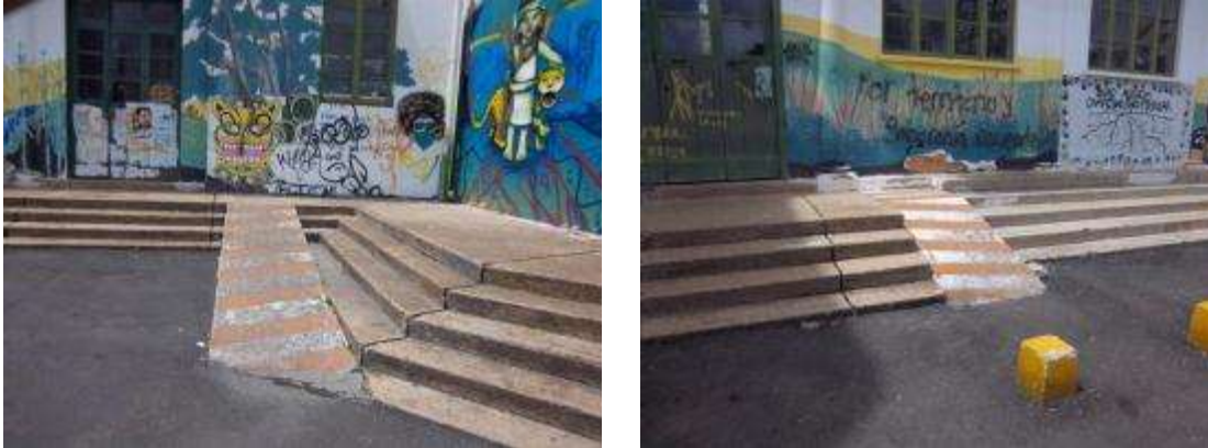
Foto 6. Rampas del edificio central Tunja
