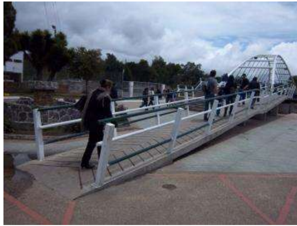
Foto 4. Puente sobre el río
