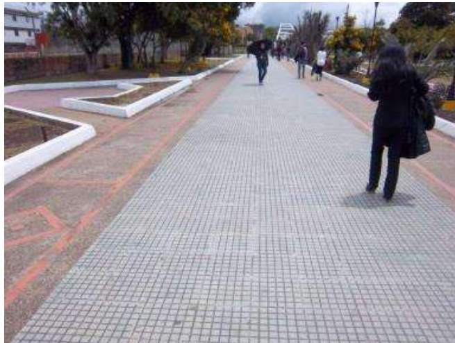
Foto 5. Piso nivelado en acceso sede Tunja
