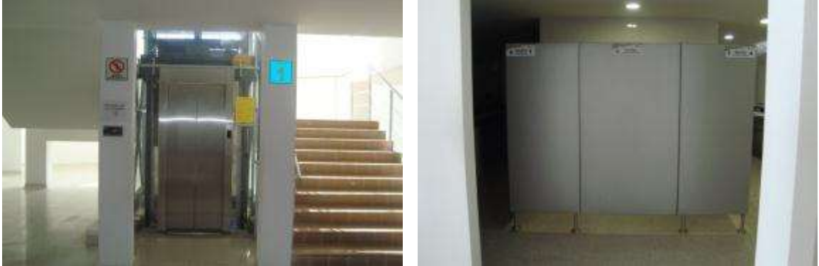
Foto 8. Ascensores del edificio de laboratorios Tunja
