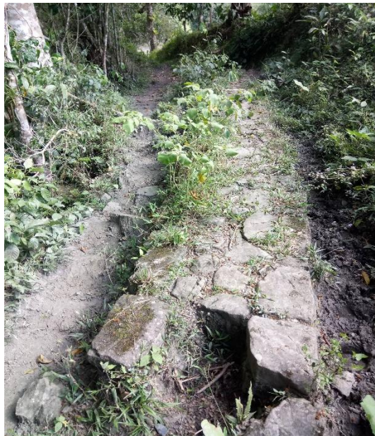
Fotografía 29, Camino en tierra y empedrado, huellas del camino, 2017
