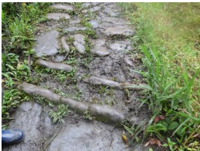
Fotografía 4. Canaletas de agua camino empedrado, 2018 Yanira Rosales.
