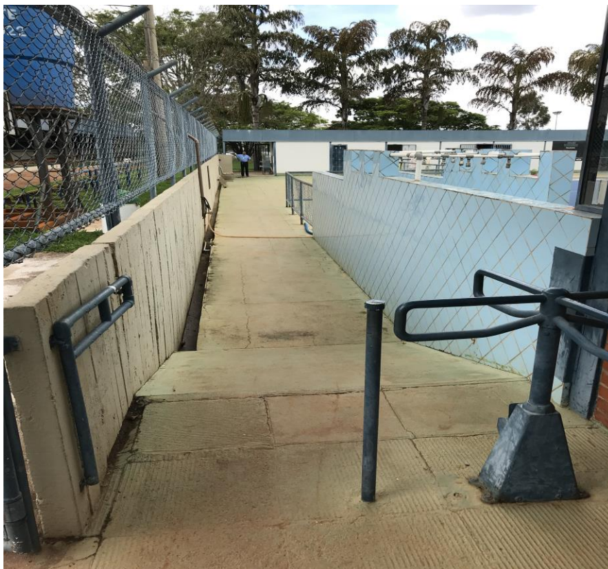
Figura 20. Área de acesso interno a piscina
