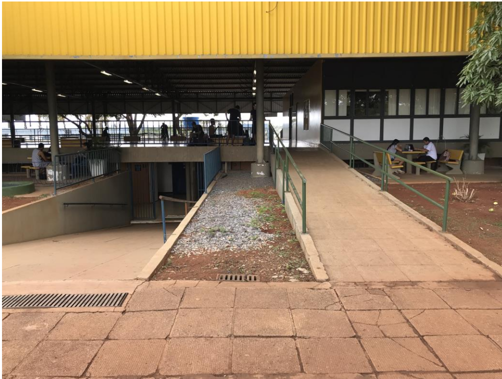
Figura 7. Rampas de acesso a parte inferior do C.O. e ao pátio
