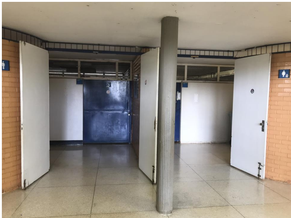
Figura 11. Acesso aos banheiros pelo corredor inferior
