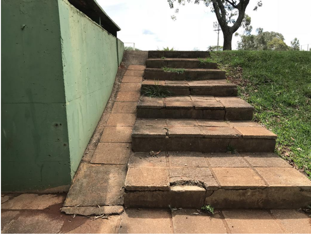
Figura 5. Calçada e rampa de acesso a quadras externas
