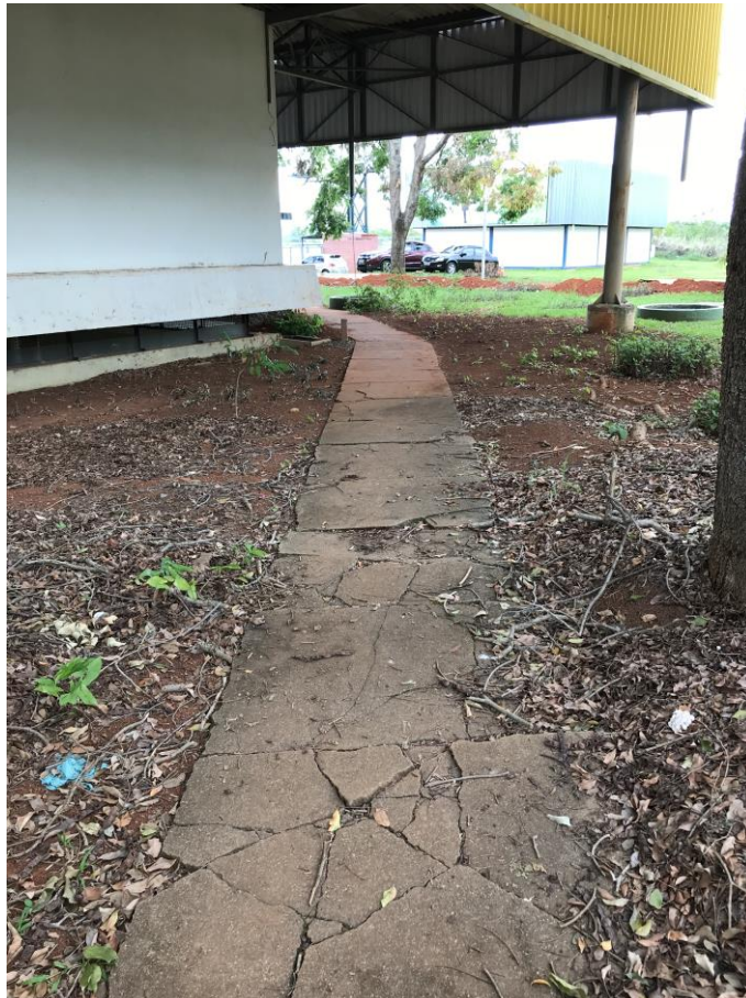
Figura 4. Calçada de acesso a piscina e quadras externas
