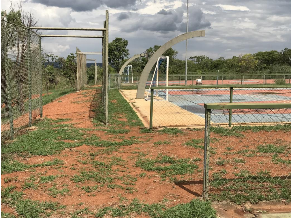
Figura 25. Acesso a quadras externas parte 2
