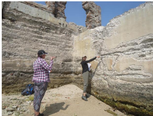
Ilustración 1.2 Identificación de la estratigrafía de los muros del aljibe. Archivo personal (2019)
