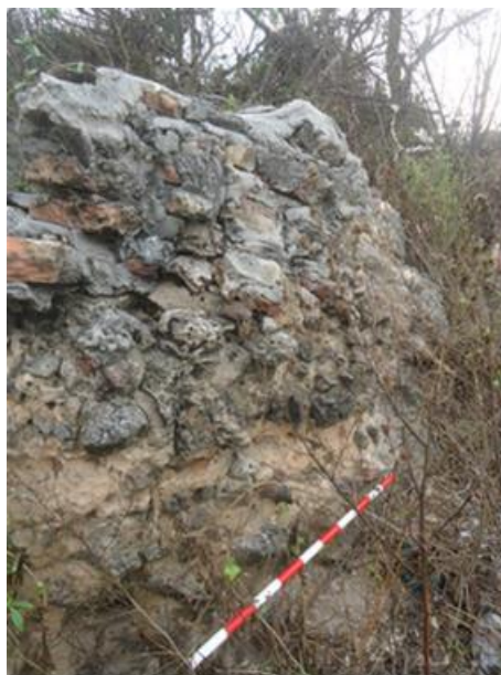
Ilustración 5.8 Detalle del cemento aplicado a la estructura. Archivo personal (2019)
