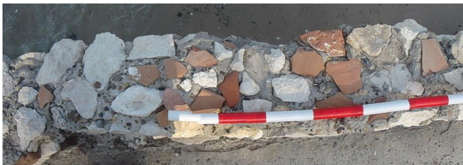
Ilustración 5.4 Muro restaurado del Pozo con elementos cerámicos
