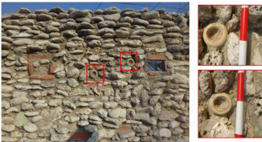
Ilustración 5.3 Muro de una casa que tiene bordes de botijas
