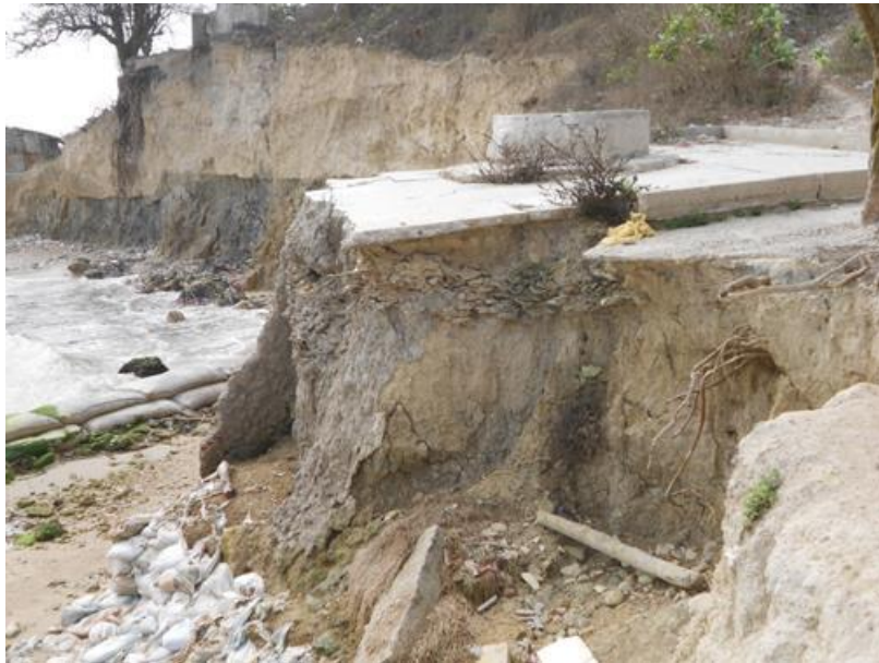
Ilustración 5.9 Fotografía del pozo cuando la Escuela Taller quedó a cargo del sitio. Archivo personal (2019)
