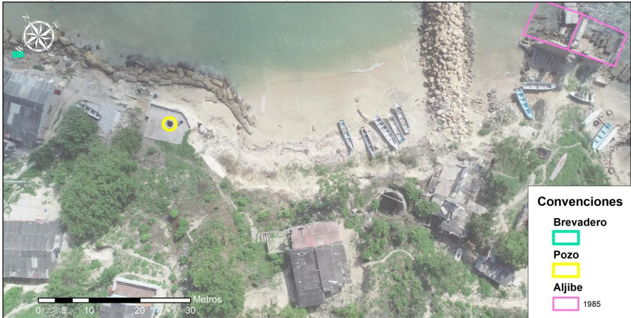
Ilustración 2.44 Zonas de almacenamiento de agua del Tejar de San Bernabé
