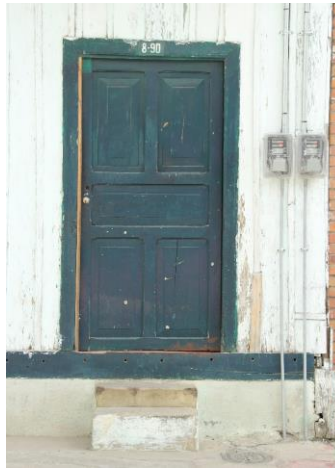
Figura 5. Durmientes perforados de las viviendas en madera.
