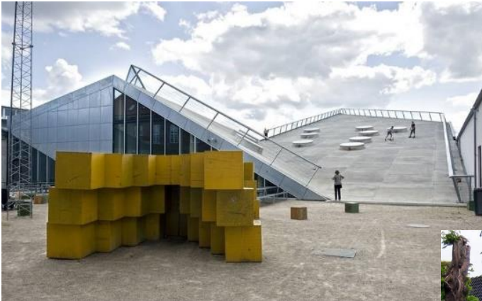
Godsbanen. Photo: Realdania
