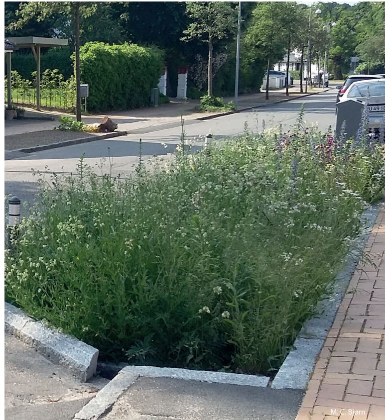
Forøgsbedene på Langelinie er et eksempel på en naturnær vegetationstype til LAR-vejbedet.
