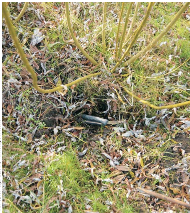
Siveslanger nedpløjet under jordoverfladen i pilemark ved Thise Mejeri.
