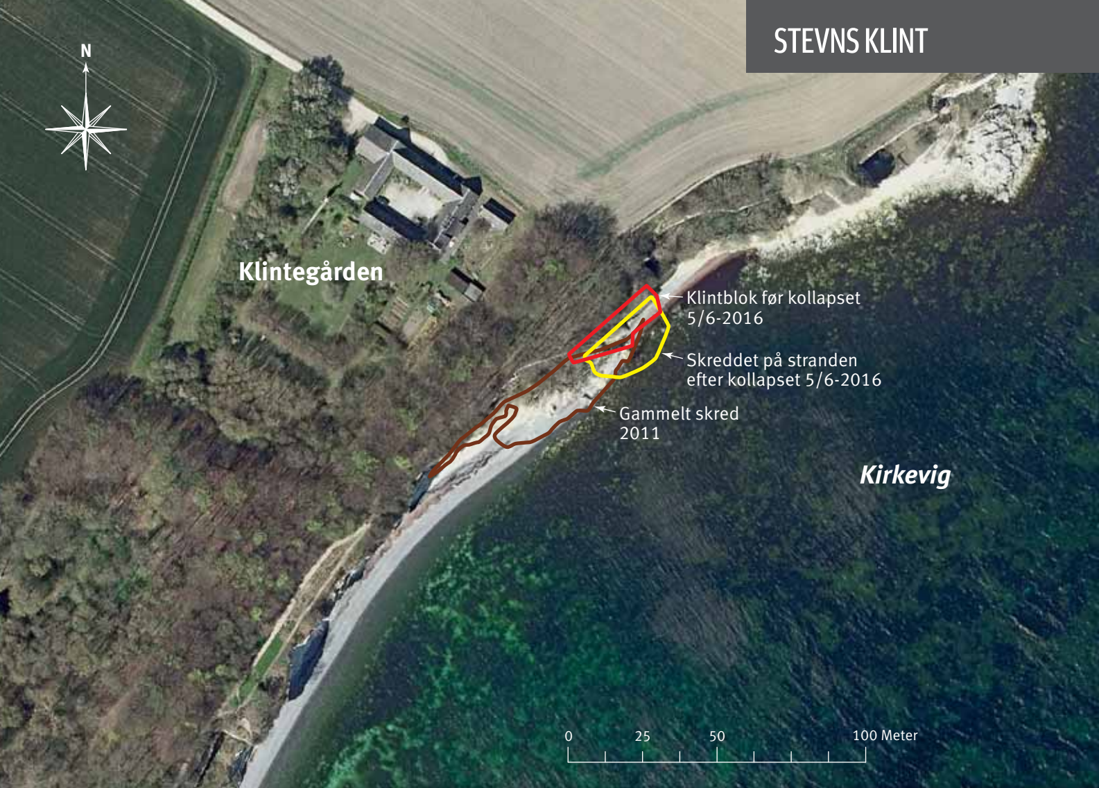
Flyfoto som viser det gamle skred ved Klintegården og den blok ved siden af, (nordøst for det gamle skred) som faldt ned 5/6-2016. Både nord og syd for skreddet ved Klintegården findes gamle kalkbrud.
