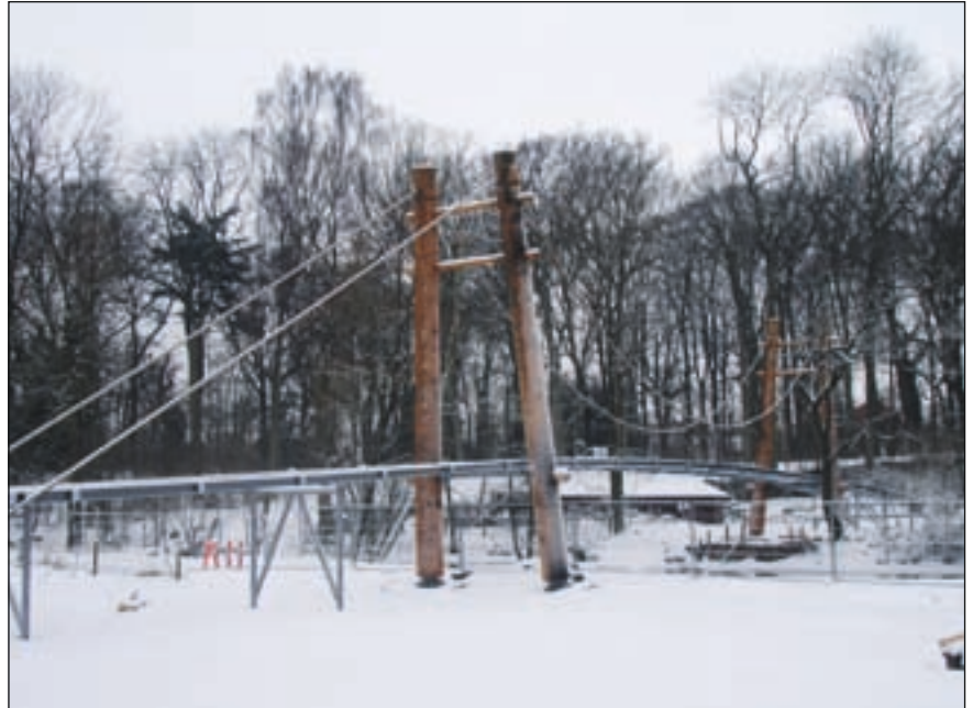
Broen blev løftet på plads med specialkraner, og den står nu som et af vartegnene for Odense Zoo.
