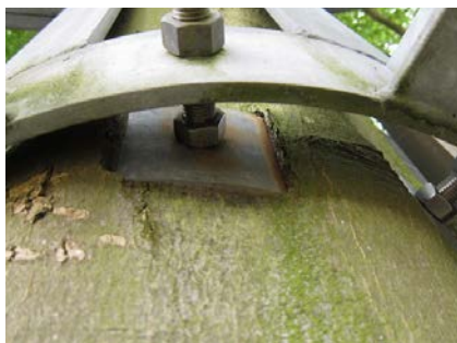
Et »trævenligt« ophæng, som ikke gennembryder barken, men alligevel slår vækstlaget ihjel og ødelægger træets transportsystem.
