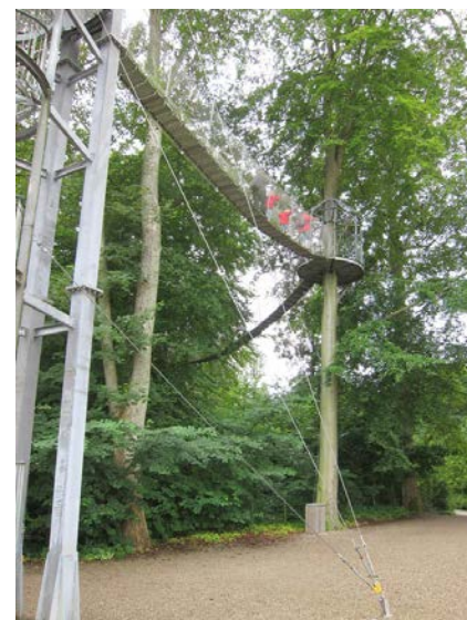
Et stort og dyrt tree-top anlæg, der skal holde i mange år. Det er afgørende for banens holdbarhed, at der tages hensyn til træerne. Første træ på banen har formodentlig rodskader efter grusudlægning og barkskader efter ophængen af platformen.
