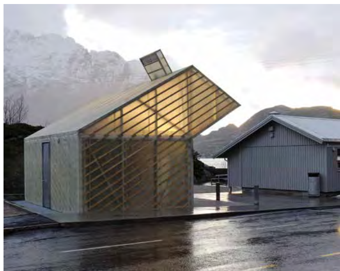
Jektvik Ferry Quay, Rødøy, Norge Carl-Viggo Hølmebakk Kilde: www.holmebakk.no
