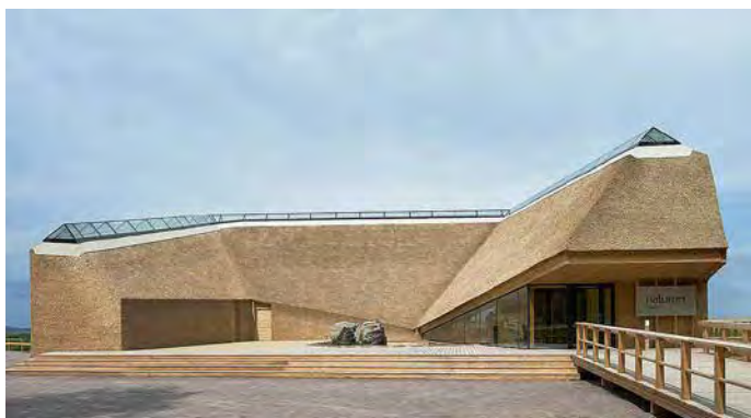
Tåkern Visitors Centre, Sverige Wingårdh Arkitektkontor Kilde: www.wingardhs.se
