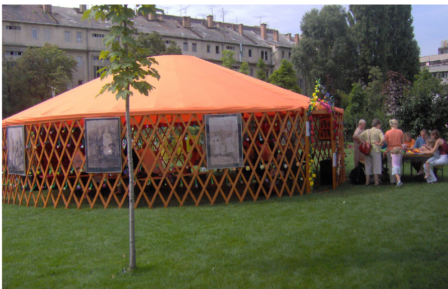
Figur 20. Yourt på otte meter i diameter. Konstruktionen kan laves med mange indgange, og kan således fungere på samme måde som udelokale.
