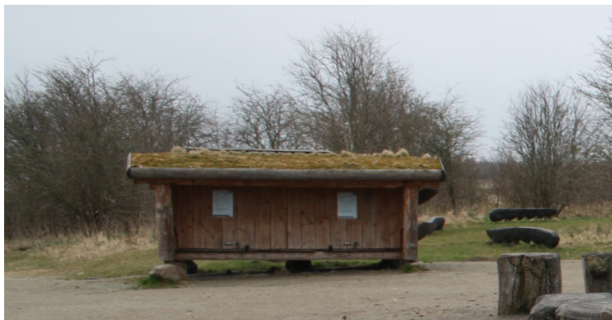
Figur 7. Aflåseligt shelter med udstyr til grupper, der har nøgle til det. Når klapperne åbnes, er der en anordning, der holder klappen, så der bliver et stort område med ly for eventuel regn.
