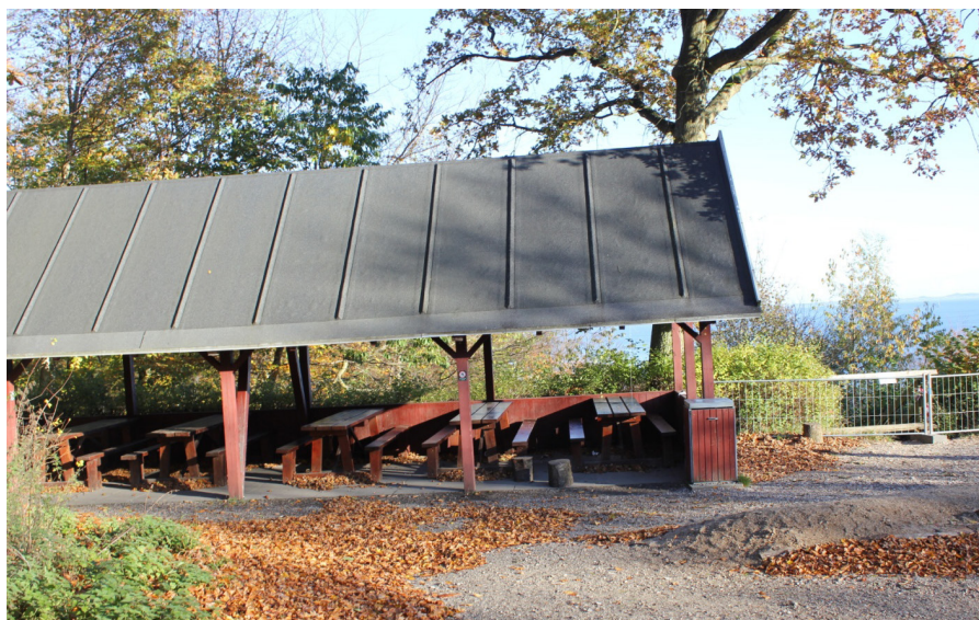
Figur 26. Ved det gamle traktørsted er der en pavillon med borde og bænke, der egner sig til samling af grupper. Pavillonen er oprindeligt bygget som en del af traktørstedet. I dag bruges den bl.a. til udeskoleaktiviteter.
