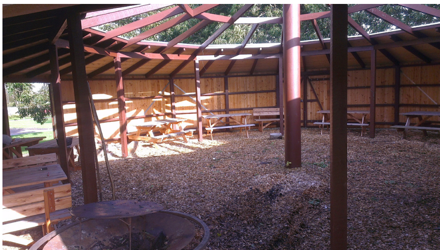
Figur 23. Udeklasselokale ved Pædagoguddannelsen Jydsk. Lokalet kan rumme ca. 40 studerende, og ud fra fire verdenshjørner kan lokalet åbnes mod arealerne omkring, og borde og bænke kan flyttes udenfor bygningen.
