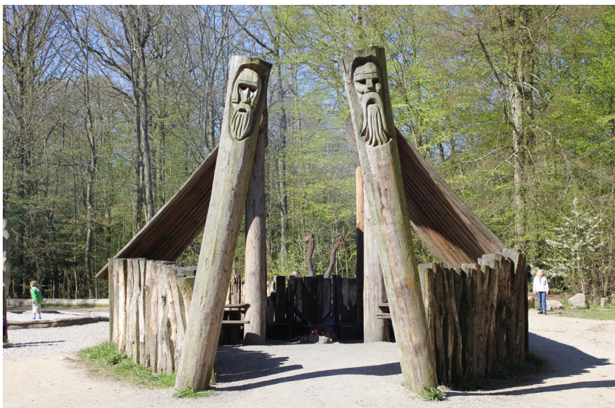
Figur 27. Samlingsfacilitet, hvor konstruktionen understøtter et stort lysindfald. Åbningen skal ideelt set pege mod syd for at understøtte lysindfald og vind fra vest, nord og øst, som er fremherskende i den kolde årstid.
