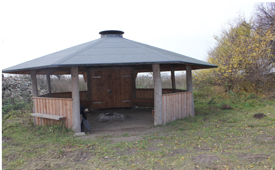
Figur 11. Bålhus ved Øllerbjerg viser standardkonstruktionen i Næstved. Faciliteten kan sagtens rumme ca. 20 børn ved samling. Den ret lukkede konstruktion gør dog samlingsrummet for mørkt og koldt på mange tider af året.
