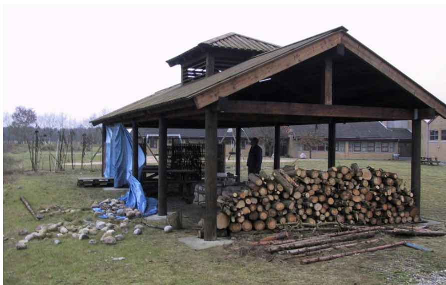
Figur 32. Bålhus placeret ved et åbent sportsareal ved en skole. Bålhuset er så eksponeret for vestenvinden, at ophold ofte kræver, at der opsættes presenninger som læ. De blafrende presenninger understøtter ikke samling.
