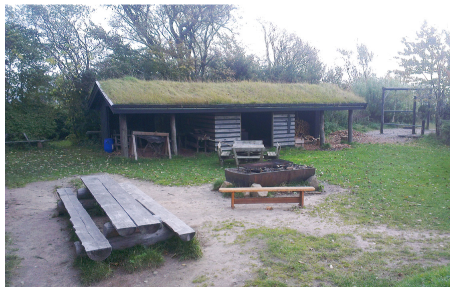
Figur 28. Huggehus ved Karpenhøj Natur- og friluftsgård på Mols. Ved huggehuset er der halvtag, som kan rumme en del mennesker, og ved bordet kan der samles ca. 20 børn.
