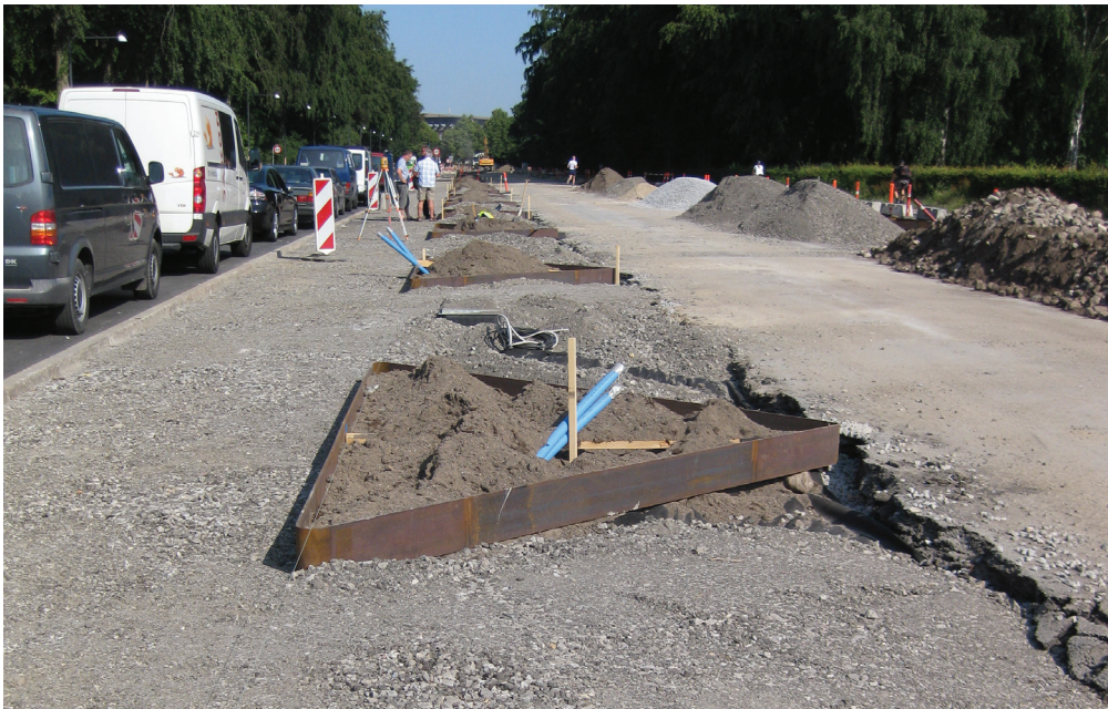
Billede: Bærelag, belægning og vækstmedium nyetableres på ØA. (Mads Madsen Krag)
