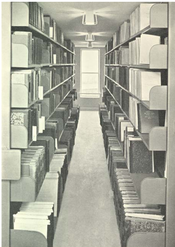
Det nye universitetsbiblioteks bogtårn fra 1938 med kompakt udnyttelse af etager, specialtegnede blændefrie lamper og elevatorsystem.
