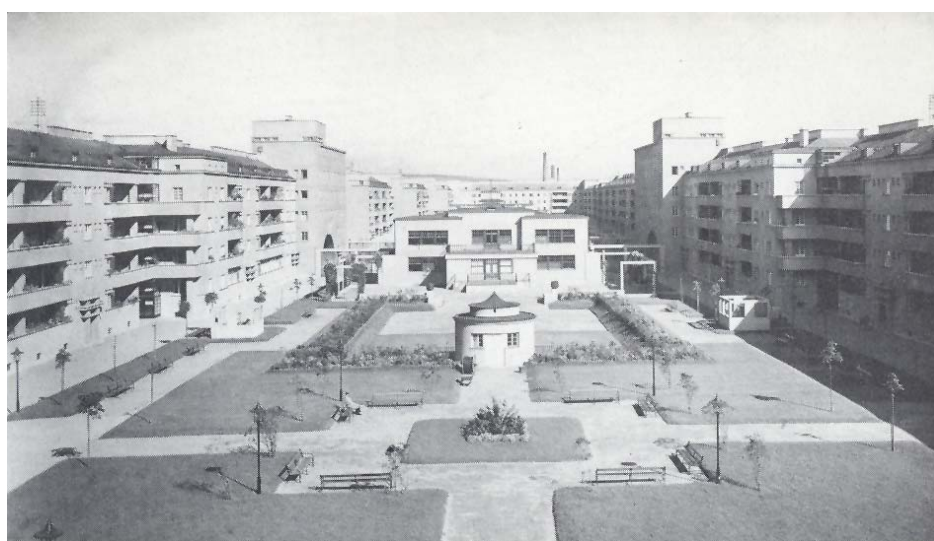
Kat. Nr. 20/2/1/3: Karl-Marx-Hof, Innenhof mit Kindergarten
