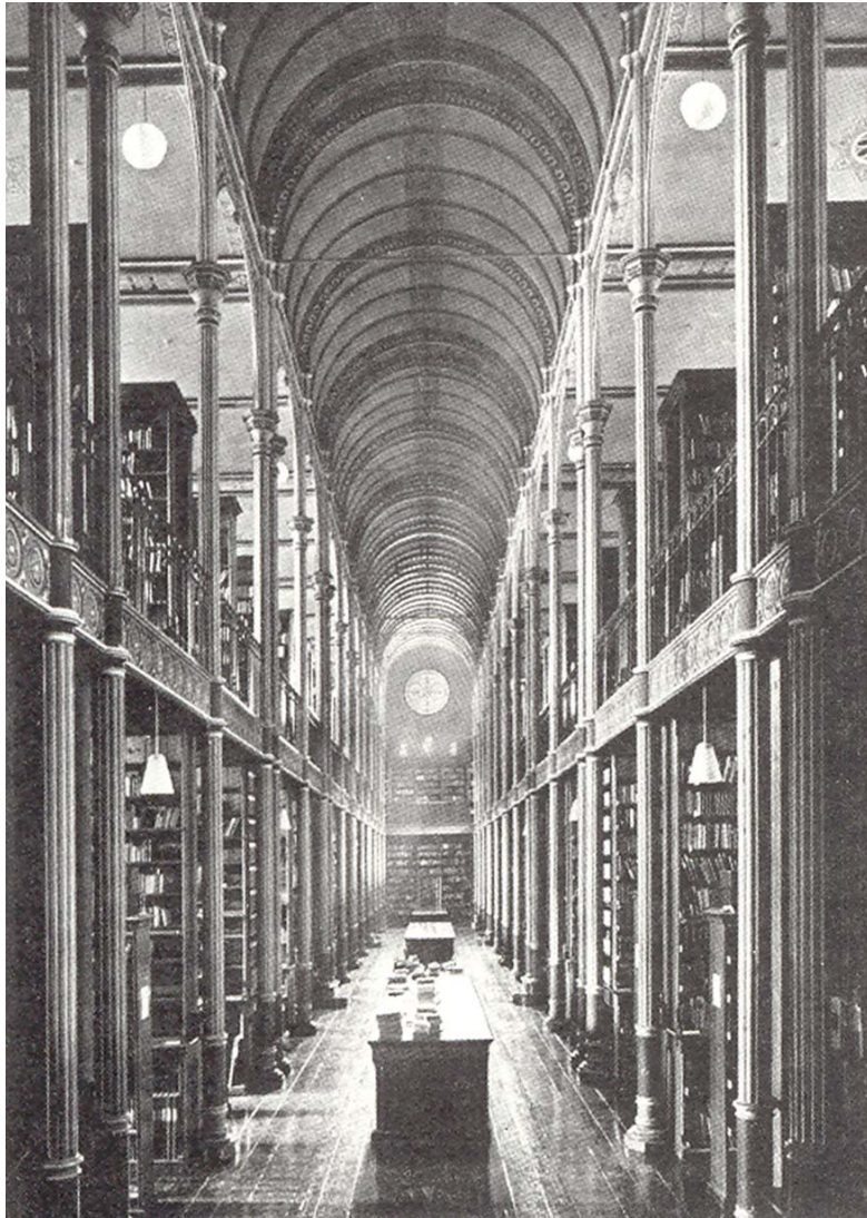
Universitetsbiblioteket fra 1861 som basilica med moderne jernkonstruktioner.
