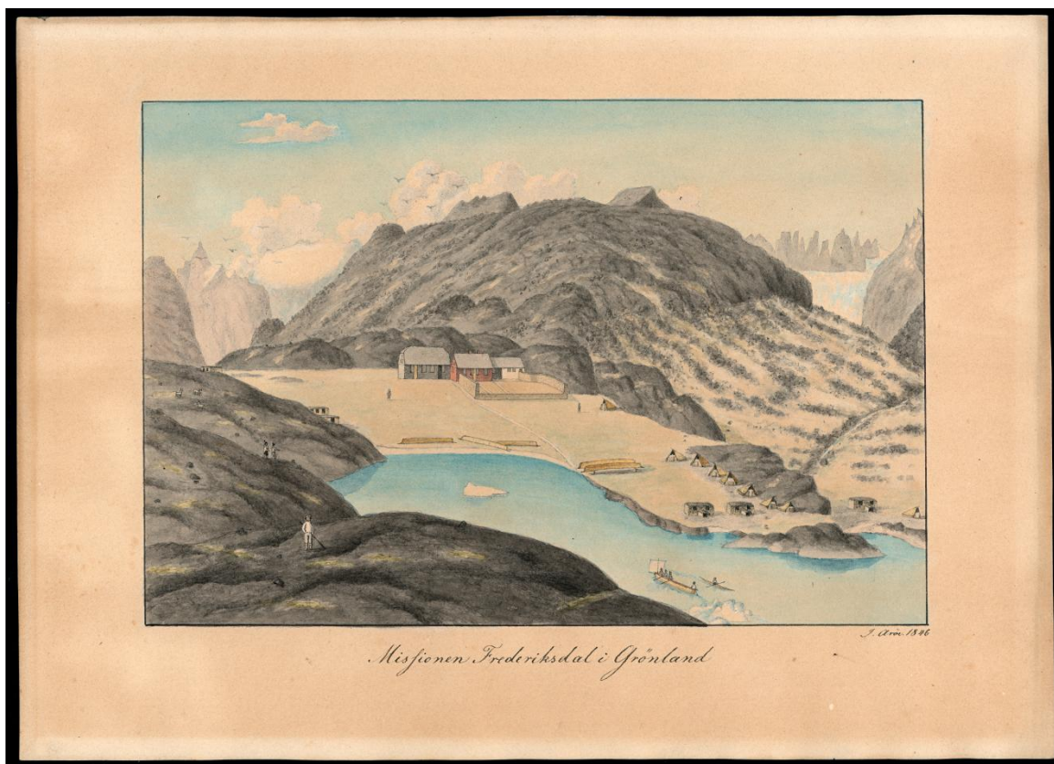
Fig. 18. Akvarel af Friedrichsthal udført i 1846 af Jakob Arøe. Der findes flere forlæg til dette billede, bl.a. fra 1834. I midten af billedet ses Brødremenighedens missionsbygninger med kirken, missionærernes bolig, gedestald og depot, samt den indhegnede have. Missionsstationen lå på en lille slette, der ligger til grund for de lokalt anvendte grønlandske navne Narsaq og Narsarmijit (sletten og slettens beboere). Til højre elven Narsap Kuua, af herrnhuterne betegnet Königsbach. Grønlændernes boliger ses bag fjeldet til venstre, samt i billedets højre side tæt ved bugten. Ved bugten ses endvidere nogle konebåde og en række telte, der kan have været beboet enten af folk på stedet, der er rykket ud af vinterboligerne, eller tilrejsende, fx fra Østgrønland. Etnografisk Samling, Nationalmuseet, L18.285.8.
