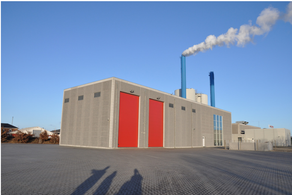
Foto: Flislager med porte til aflæsning. Bemærk riste i væggene til ventilation. Resultaterne tyder på at afkast over tagniveau medfører et lavere sporeniveau nær værket.
