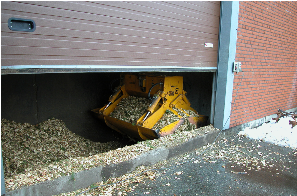
Foto: Det er almindeligt, men ikke hensigtsmæssigt, at benytte ukontrolleret ventilation af lageret. Aktiv udsugning med afkast over tagniveau, er at foretrække.
