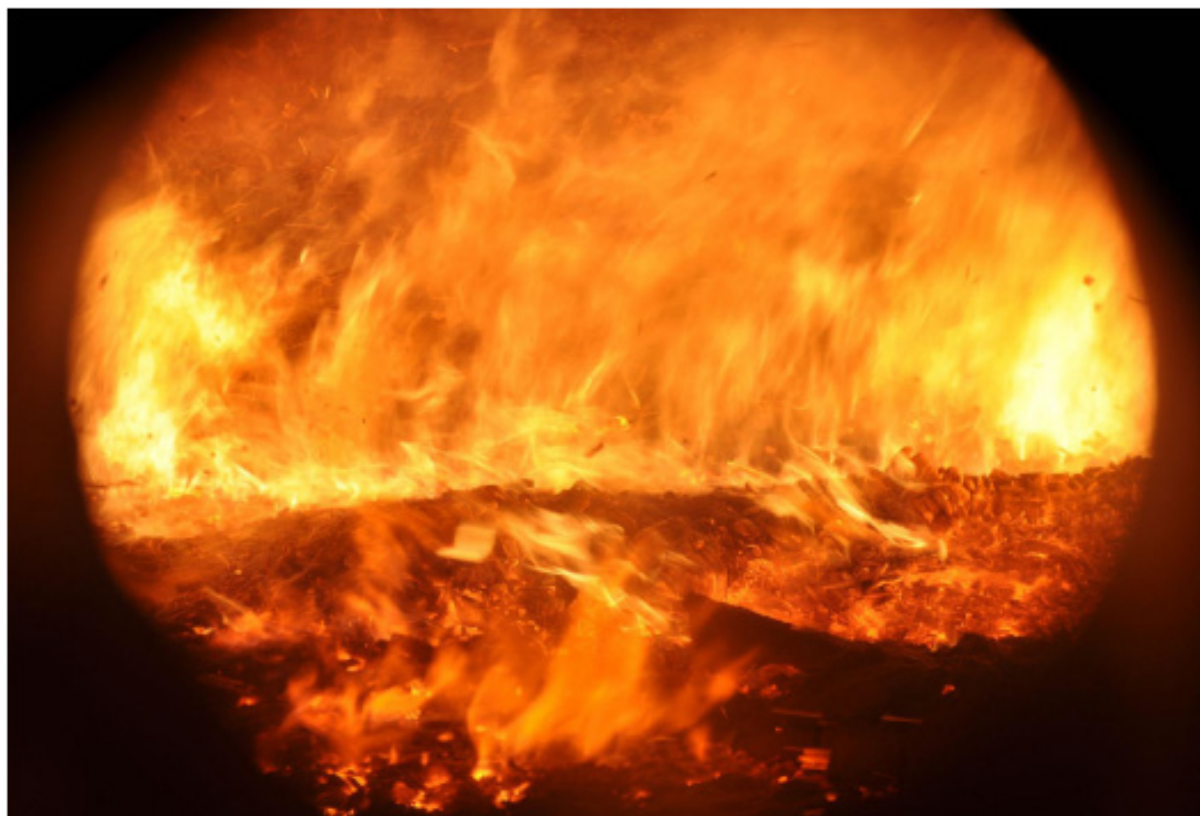
Fyrboxen hvor flis brænder under dannelse af små mængder PAH og dioxin.
