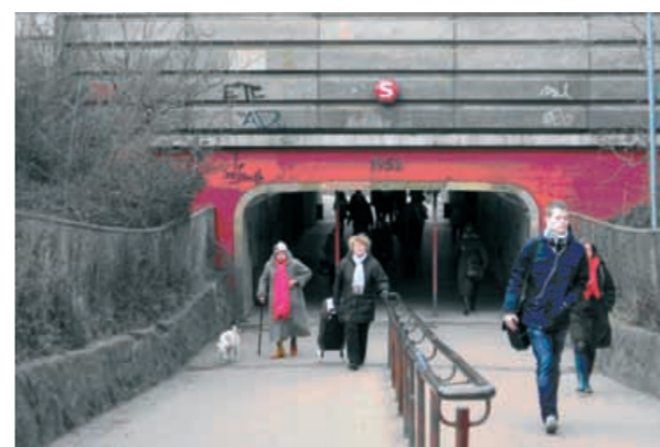
Tunnelen syd fra. Nordsiden ser lige sådan ud.
