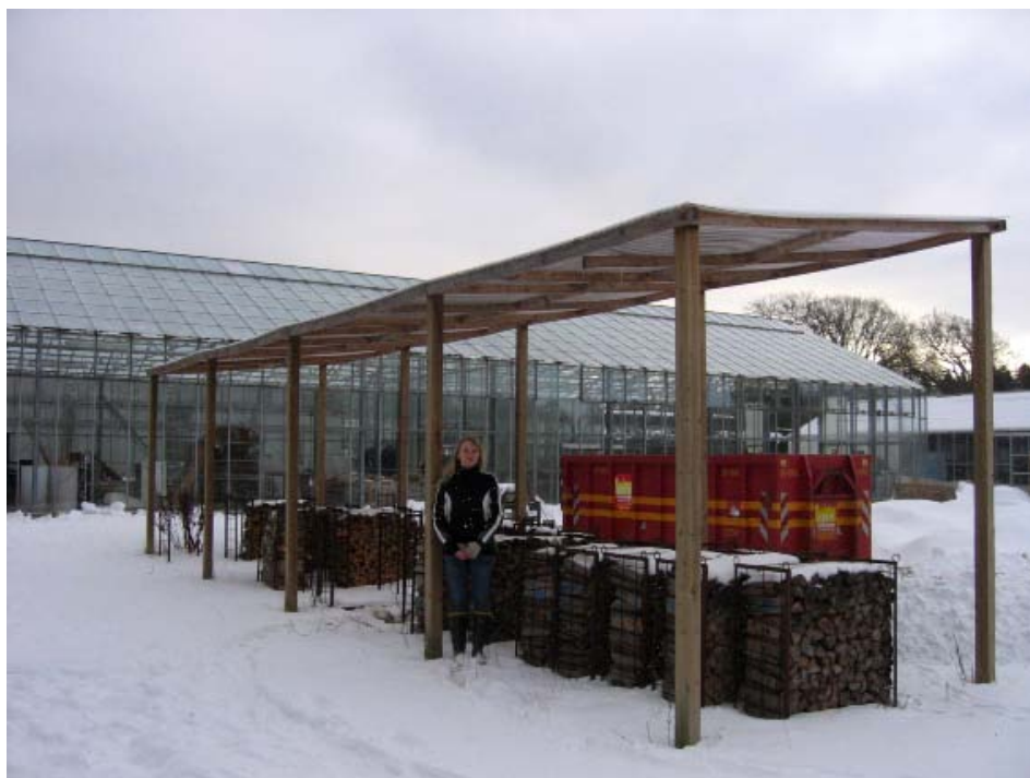
Figur 3. Det anvendte halvtag er på ingen måde ideelt. Af hensyn til vejning af rammerne måtte halvtaget bygges (for) højt over brændet.
