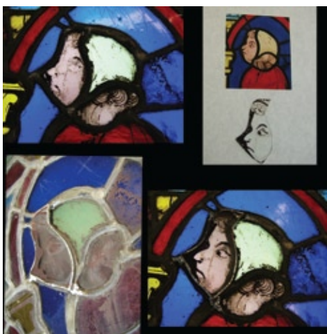
Så snart man har fjernet de oprindelige jernsprosser fra vinduespanelerne og har undersøgt forringelserne, skal glarmesteren undersøge og datere glassene. Han bevarer vinduesglas fra det 13. århundrede, selvom de er meget ødelagte eller har en forkert farve. De andre vinduer istandsættes eller udskiftes. Hvis glasvinduernes tegning er forsvundet, skal der laves en ny tegning, ikke på de originale glasvinduer, men i stedet på nye dobbeltruder. Øverst til venstre: Rudens aktuelle tilstand. Øverst til højre: Studie af personernes ansigts-træk. Nederst til venstre: Gamle glasvinduer blyindfattes igen. Nederst til højre: Resultatet. Foto: © Vitrail France
