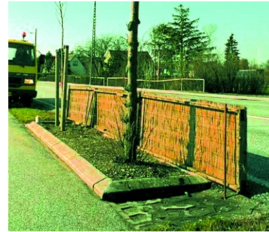
Kantsten rundt om plantehullet forhindrer smeltevand med salt i at løbe direkte ind i beddet.
