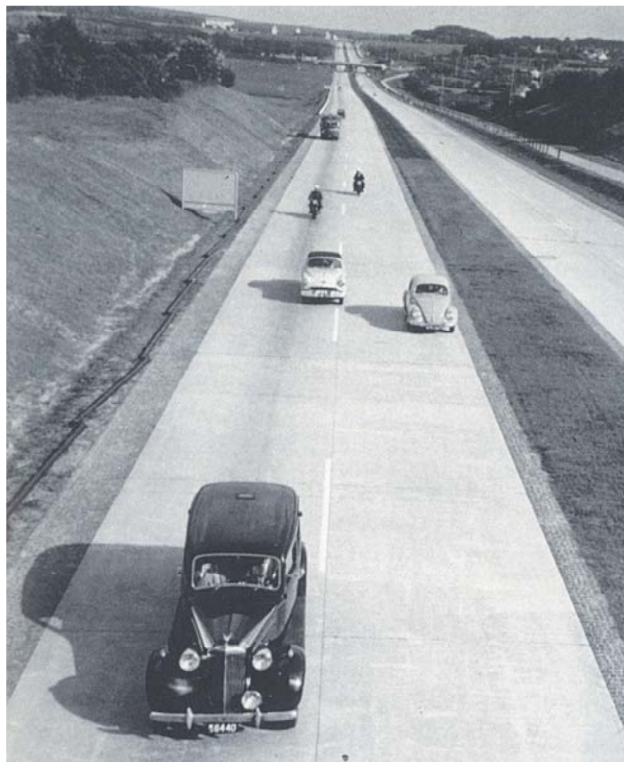
Figur: Eksempel på de første motorvejsprofiler. På Hillerødmotorvejen, blev selve motorvejen blev udlagt med en smal 4 meter bred midterrabat efter et projekt af Københavns Amts Vejinspektorat. Motorvejen blev de første strækninger anlagt i et 100 meter bredt profil efter et "parkway" ideal, der sikrede en landskabelig bearbejdning og tilplantning med god afstand til naboer. ADT: 40.000. DVT 4/63 side 49-55.
