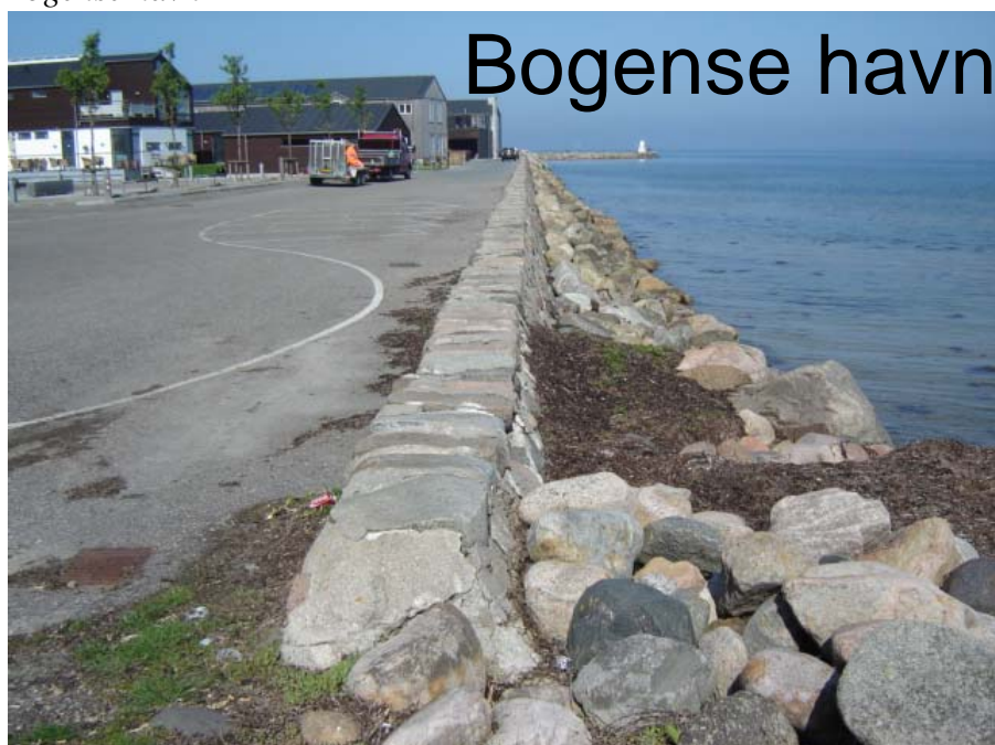
Fig 64. Billede af indmålt kajkant ved Bogense havn. Billedet er taget mod nordvest.
