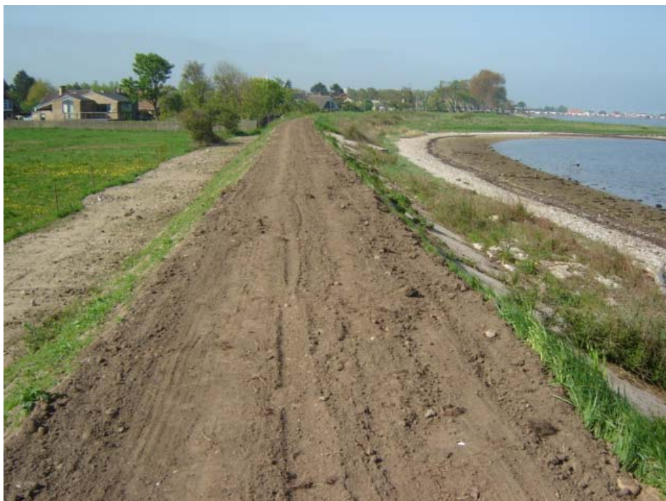
Fig 51. Billede af området omkring E. Billedet er taget mod øst. Der er for ganske nyligt sket en reparation/genopbygning af diget.
