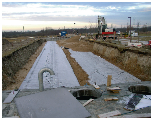
Figur 2. Her ses DPF-18 og DPF-6 i prøveanlægget i Ørestad – begge er indpakket i en PE-membran.
