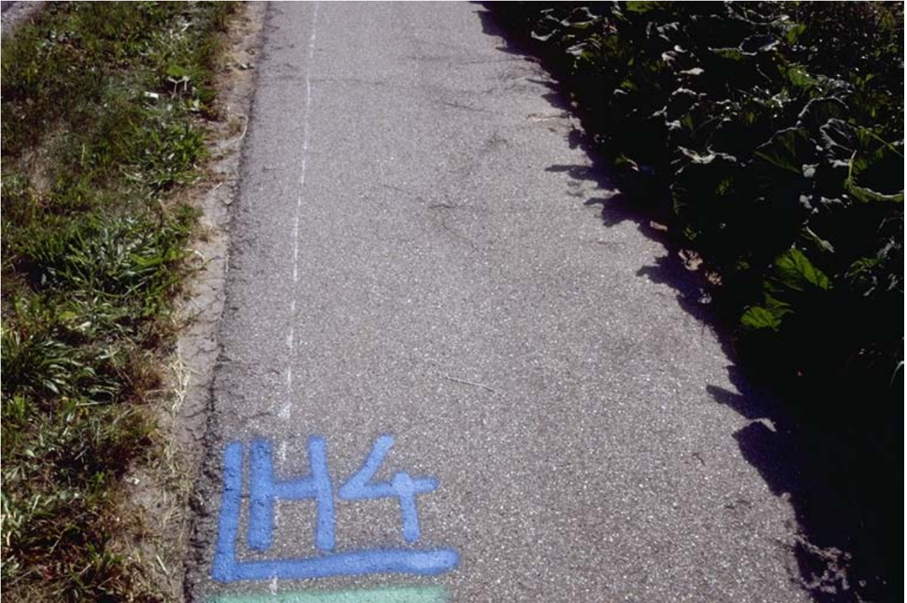
Figur 12. Billede fra 2. juni. Der har været udført én behandling med hedvand 4 uger forinden. Fejet parcel.
