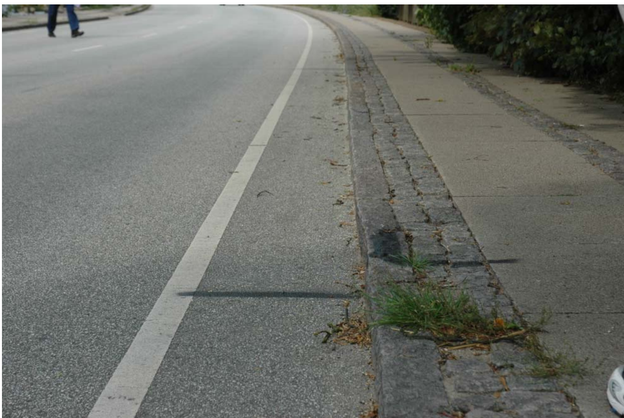
Figur 12. Billede fra Sæby den 24. august. Fra den sorte markering og frem er der foretaget dampbehandling. Bagud er der ikke foretaget nogen behandling.
