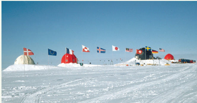
A. Sådan så NordGRIP-lejren ud i 1996, da den lige var bygget færdig. Telte og bygninger er placeret på forhøjninger af sne, så de ikke bliver dækket så hurtigt af sne. Hvert år falder der nemlig mere end ½ m sne ved NordGRIP, så i løbet af 10-15 år vil lejren være helt dækket af sne.
