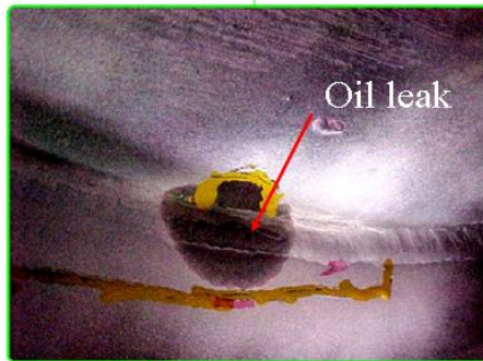
Após reparo foi detectado vazamento por trinca passante.
