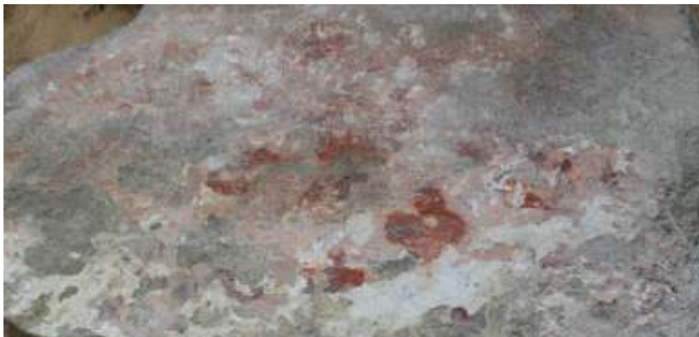
Obrázek 25 Staříč, kostel Povýšení sv. Kříže, povrchová úprava klenebního žebra šablonovou malbou.
