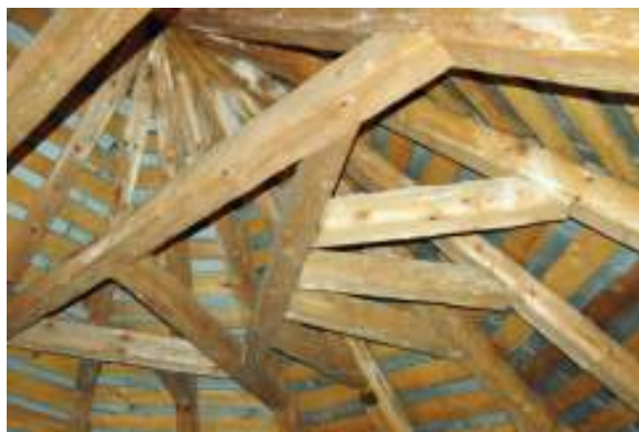
Pohľad na pôvodné umiestnenie výmeny hambálku v krove
