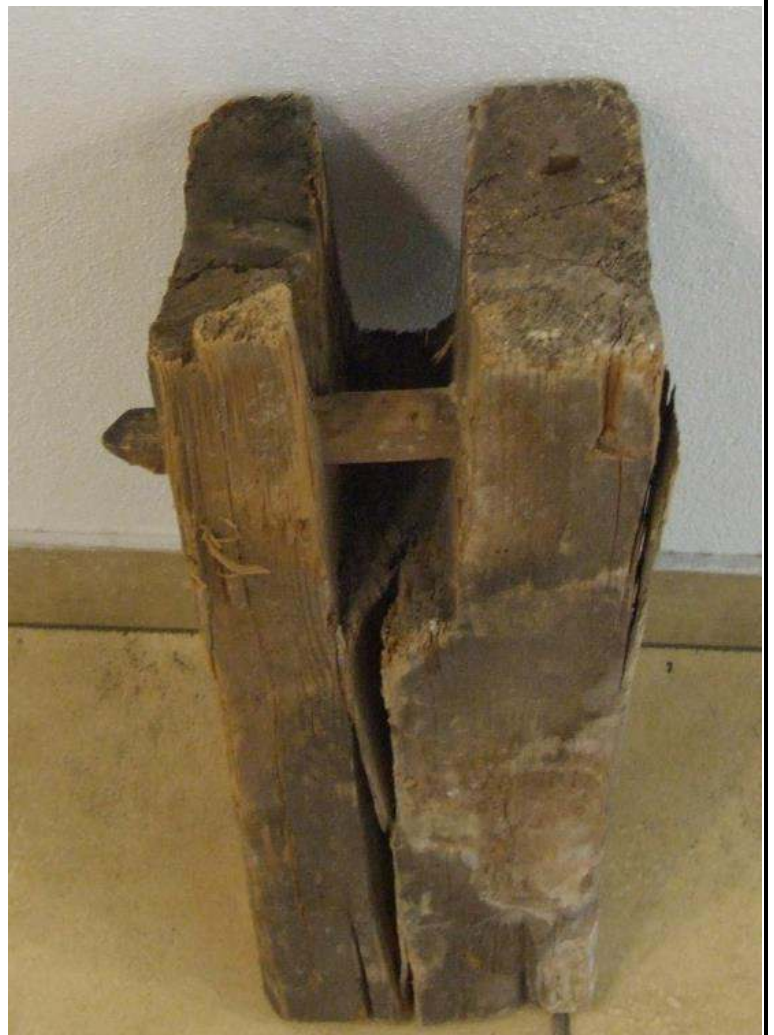
Vidlicová časť vrcholového čapu s fixačným kolíkom
