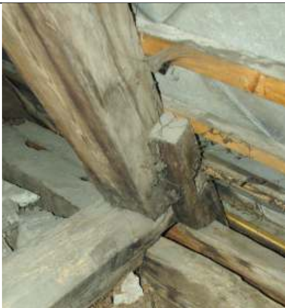
Pohľad na pôvodné umiestnenie námetku
