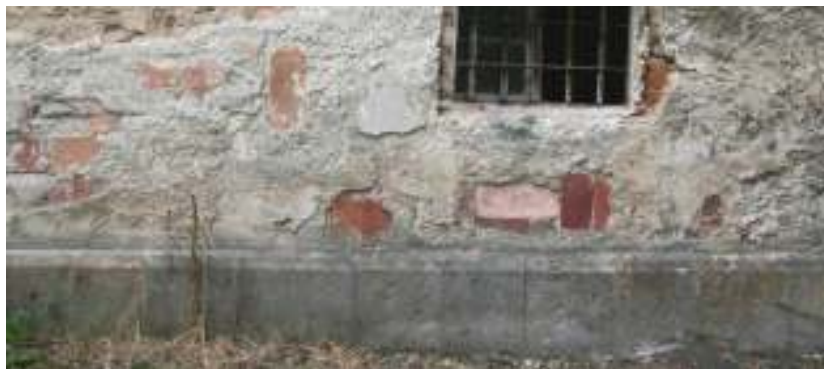
Obrázek 27 Javorník, dům čp. 7, detail jihozápadního průčelí s vyrovnávkami zdiva se starých keramických tašek, foto, 2015.
