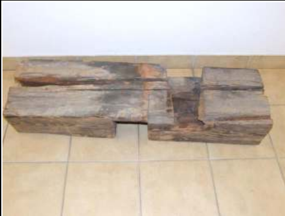
Pohľad na pomúrnicu s dlabmi.
