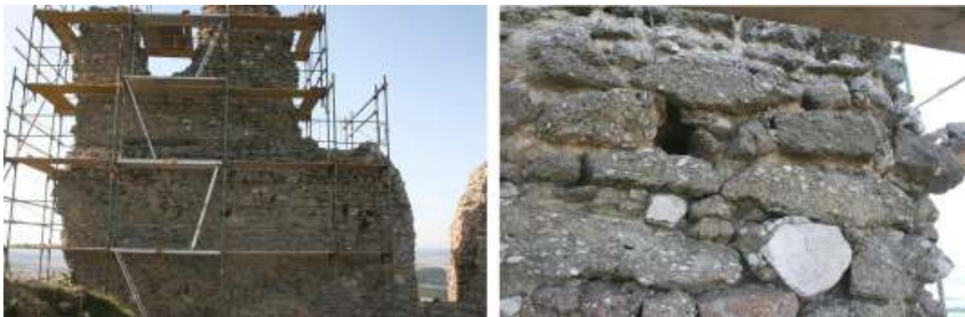
Obrázek 3 Hrad Starý Jičín, západní zeď jádra a detail východní strany zdi z chlebovického slepence, foto, 2013.
