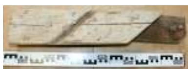
Obrázek 11 Rychvald, zámek, prvek hrázděné příčky z 2. NP.
