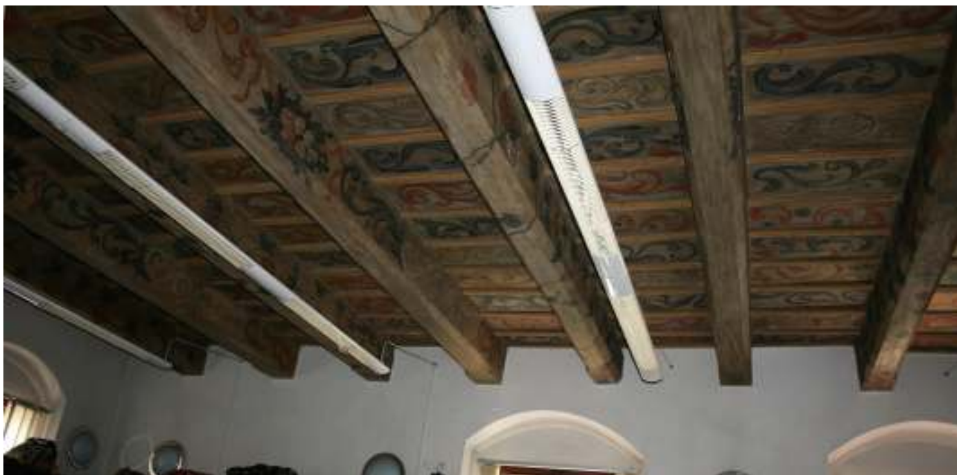
Obrázek 14 Opava, městský dům čp. 288 ( Gotteswinckel ), pohledový trámový strop s výmalbou, 2009.
