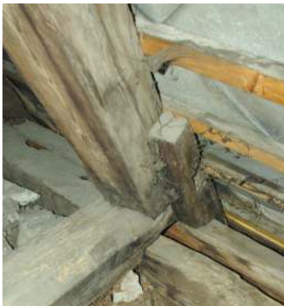
Pohľad na pôvodné umiestnenie námetku
