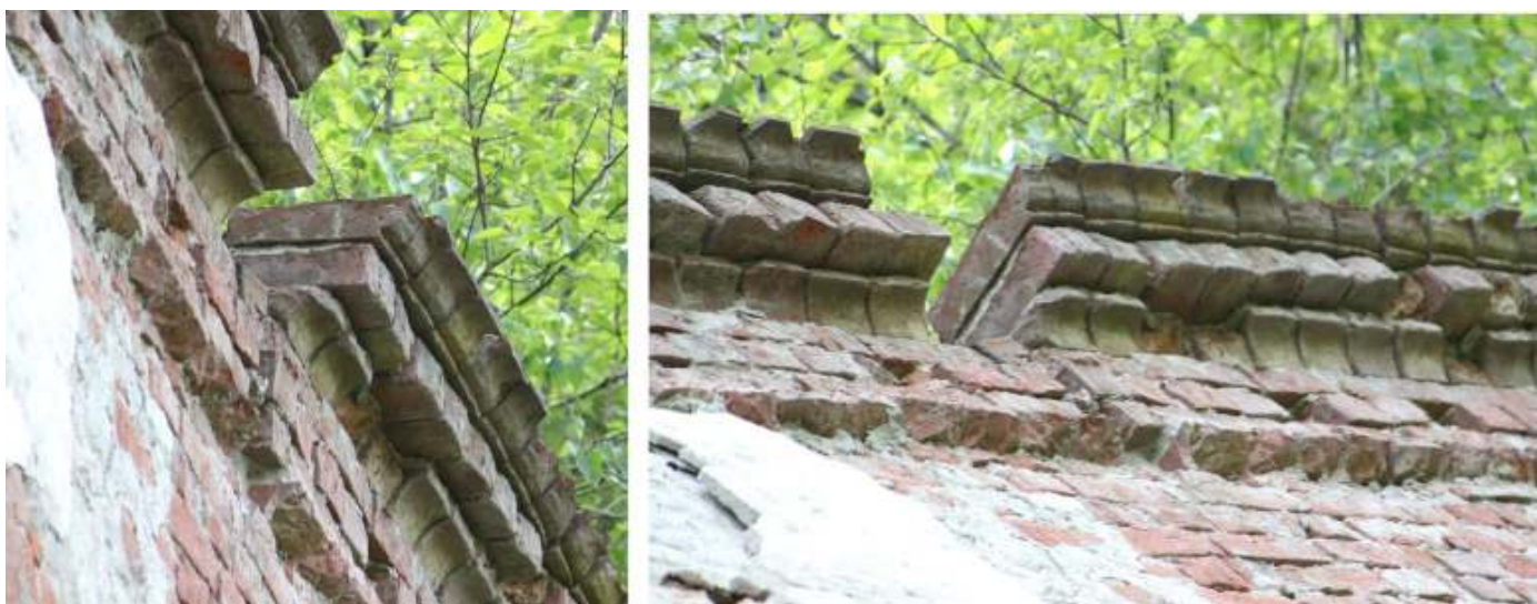
Obrázek 8 Ostrava - Kunčice, zámek, skladba korunní čímsy, foto, 2007.
