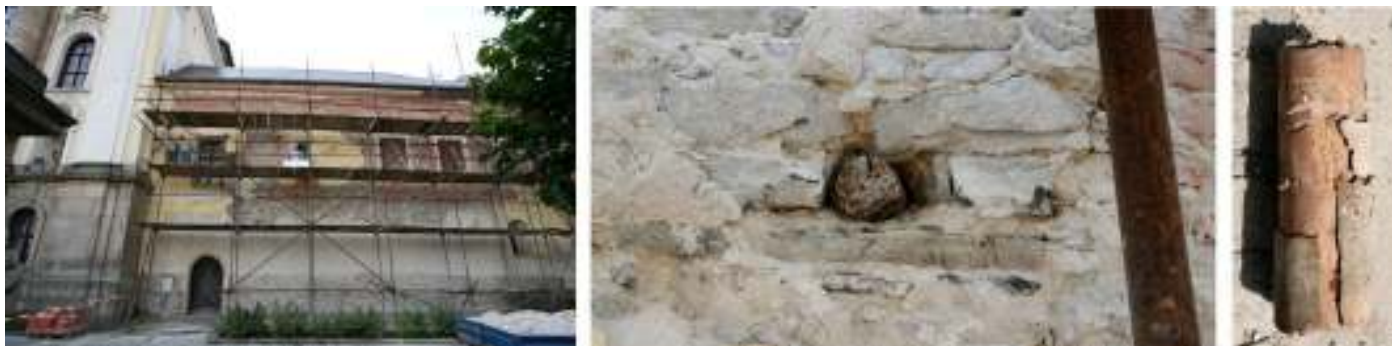
Obrázek 31 Fulnek, fara, situace s odkrytými nosníky zabudovaného lešení.
