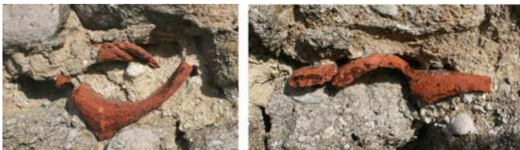
Obrázek 18 Starý Jičín, hrad, zvýšení západní zdi jádra, prejzy sekundárně použité jako zdivo, foto, 2013.
