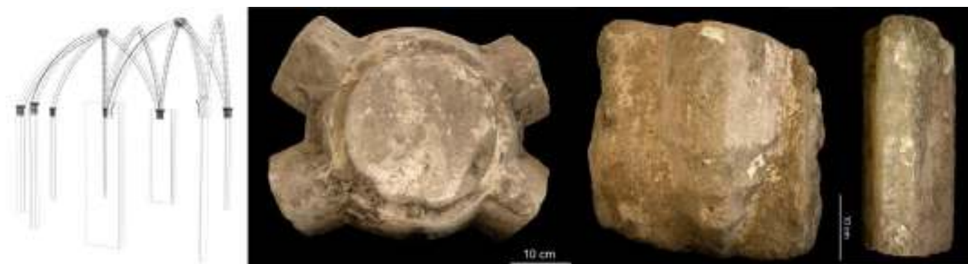
Obrázek 29 Stačič, kostel Povýšení sv. Kříže, rekonstrukce žebrového systému klenby, nákres L. Kolarčíková, 2013, svorník, klenební patka, klenební žebro, foto, 2012.
