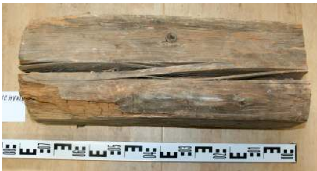
Obrázek 13 Rychvald, zámek, stropní trám s okosenými hranami, 18. Století.
