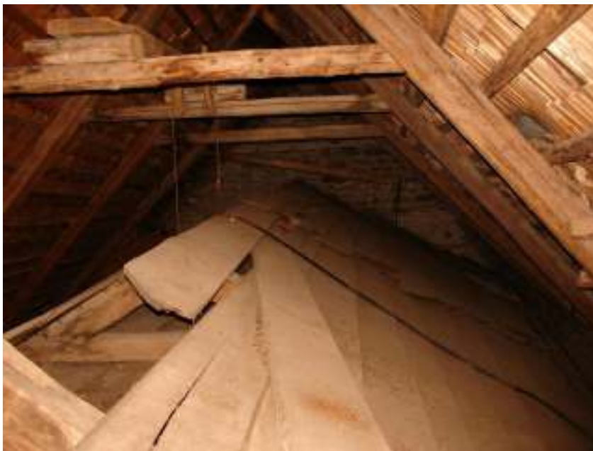
Obrázok 16 Pohľad do už neexistujúceho krovu renesančného Rímskokatolíckeho kostola v Hornej Lehote.
