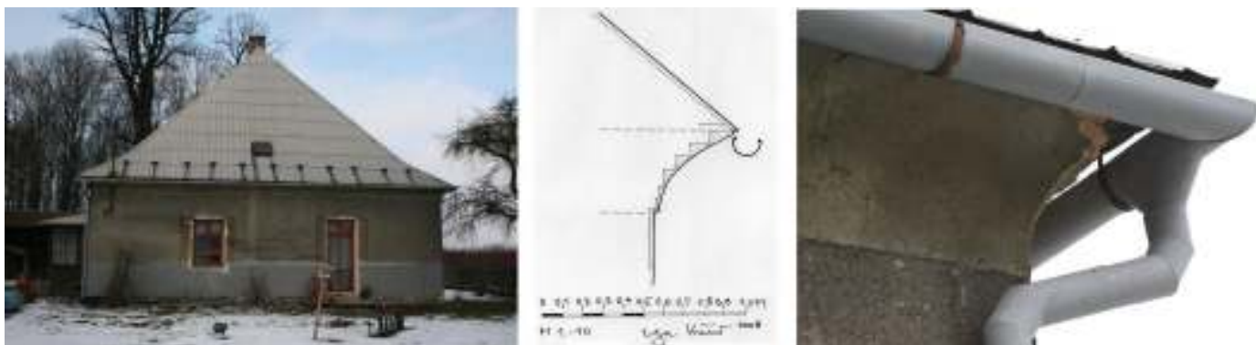
Obrázek 7 Hrabětická hájovna, průčelí, náčrtek římsy a detail římsy v nároží. Náčrtek I. Krčmář.
