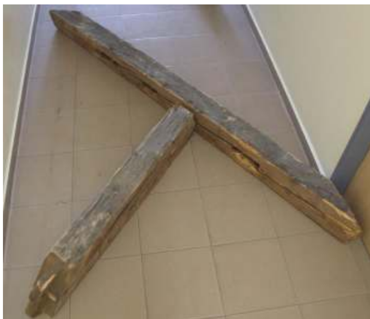
Pohľad na zloženie prvkov výmeny hambáلكu so skrátеныm hambáلكom
