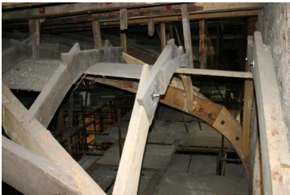
Obrázek 33 Horní Slavkov, kostel sv. Jiří, pohled do rubu bedněné klenby z prostoru podkroví, foto, 2008.
