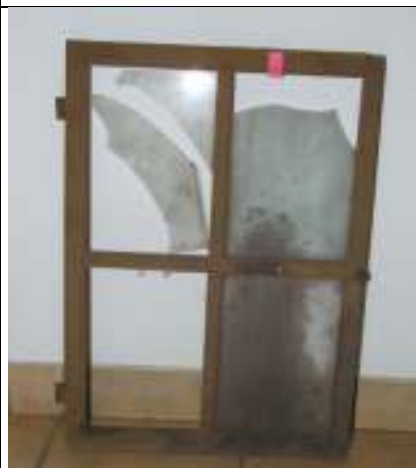
Krídlo dreveného okna
