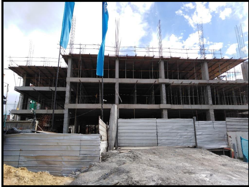
Imagen 8 - Fachada Milá - Costado Norte
