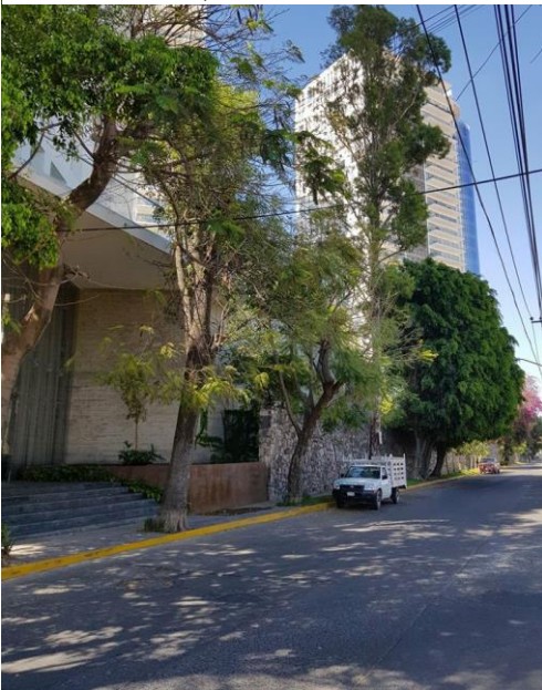
Fotografía 16. Ingreso peatonal a departamentos Autora: Cortés, S.
