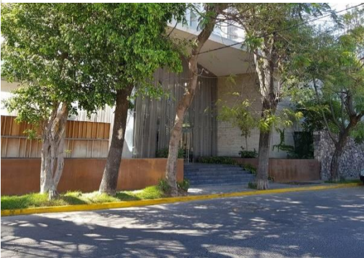
Fotografía 18. Ingreso peatonal a departamentos Autora: Cortés, S.
