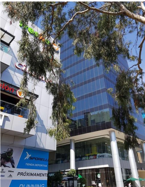
Fotografía 10. Fachada oficinas y centro comercial Autora: Cortés, S.
