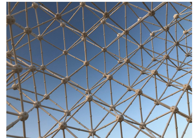
Vista interior de la cubierta del prototipo.
