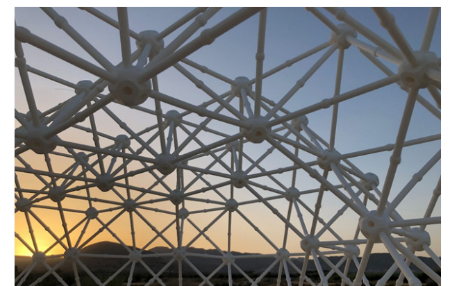
Vista del encuentro de las paredes y cubierta del prototipo.
