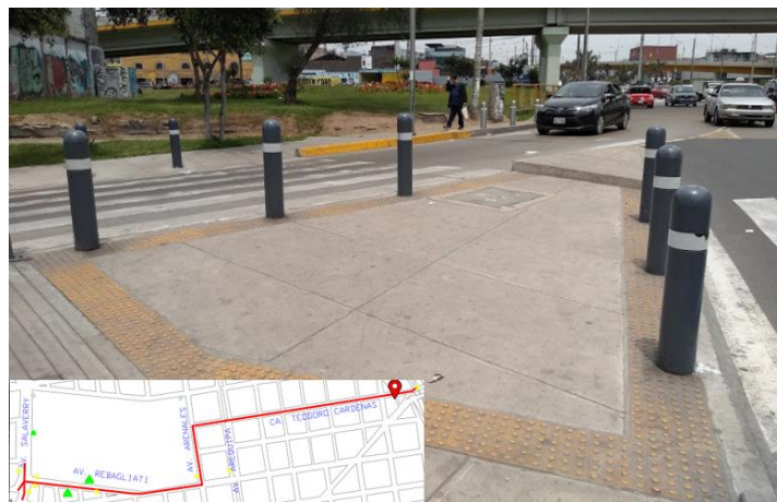
Figura 4.16 Bolardos y piso podo táctil en las intersecciones. Fuente: propia
