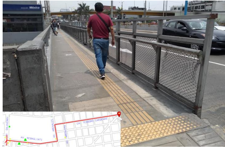
Figura 4.21 Piso podó táctil en inmediaciones de estación México del Metropolitano Fuente: propia
