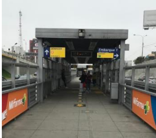
Figura 5.12 Instalaciones del Metropolitano óptimas para colocaciones de paneles solares. Fuente propia
