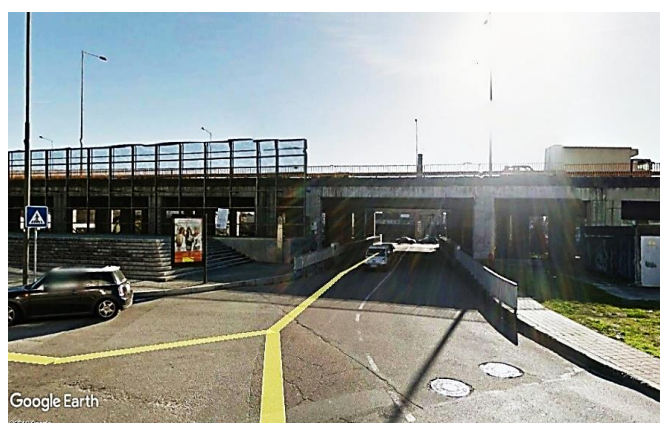
Imagem 39 – Viaduto - Rua de São Roque da Lameira
