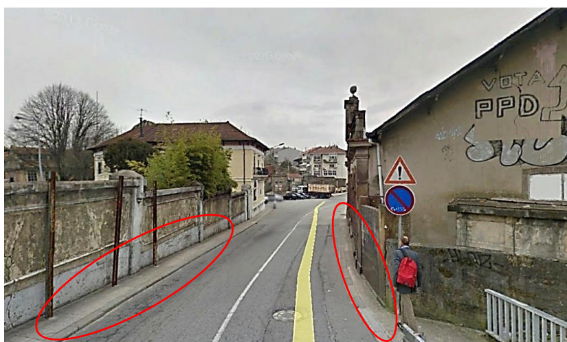
Imagem 47 – Estrutura de passeio da rua São Roque da Lameira
