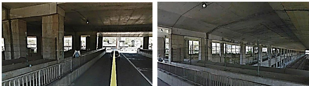
Imagem 41 – Interior viaduto – Rua de São Roque da Lameira
