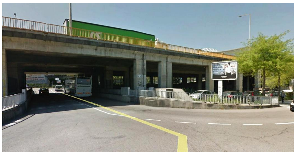
Imagem 42 – Viaduto – Fachada para Campanhã - Rua de São Roque da Lameira
