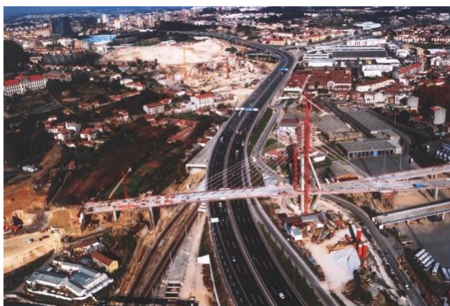
Imagem 05 – Construção da Via de cintura interna sob a freguesia de Campanhã, 2003.
