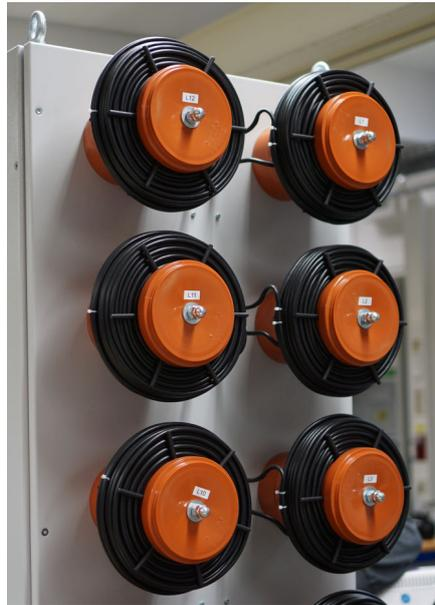
Abbildung 5.12: Foto der oberen 6 der insgesamt 12 vorhandenen Zweiginduktivitäten auf der Rückseite des Schaltschranks; als Luftspulen realisiert
