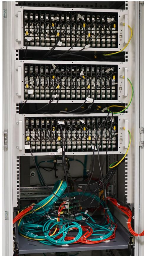
Abbildung 5.11: Foto des Schaltschranks; drei Trägerplatten mit jeweils 18 Modulplatten oben, Protolar ControlCube unten
