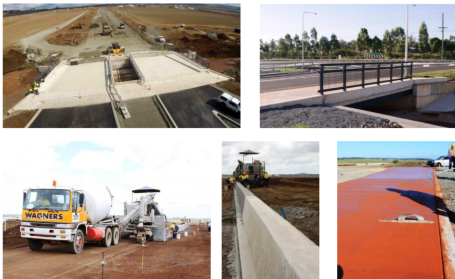
Εικόνα 4.6. Διάφορα τμήματα του αεροδρομίου που χρησιμοποιήθηκε γεωπολυμερές σκυρόδεμα [39]
