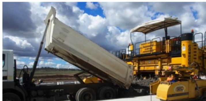
Εικόνα 4.5. Μεταφορά του σκυροδέματος στη μηχανή οδοστρωσίας [38]
