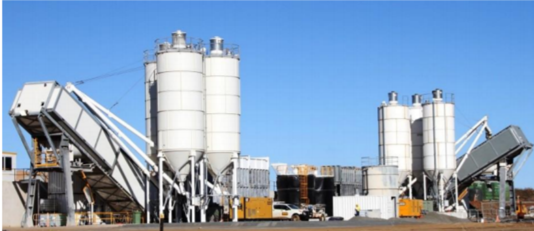
Εικόνα 4.4. Φωτογραφική απεικόνιση της διάταξης παρασκευής σκυροδέματος [39]
