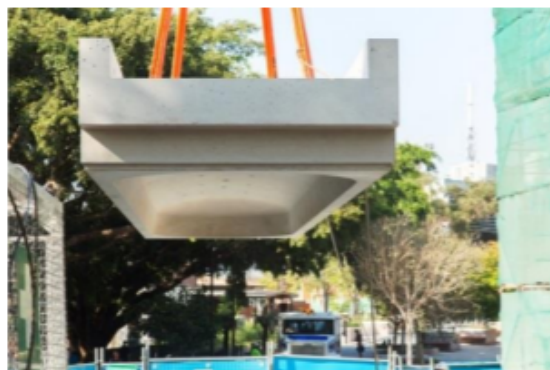
Εικόνα 4.8. Τοποθέτηση δοκών δαπέδου στο κτίριο GIC [42]
