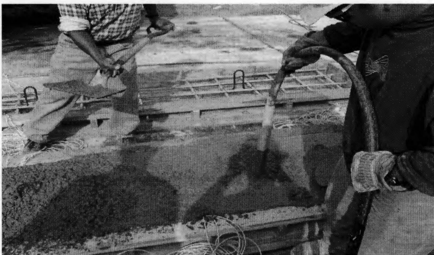
(d) Concrete Pour
