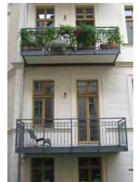
Balkonneubau mit vertikalem Stahlgeländer
