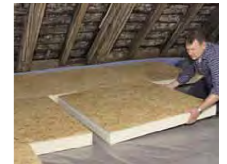
Schnitt durch die oberste Geschossdecke: Dämmung mit begehbaren Platten
