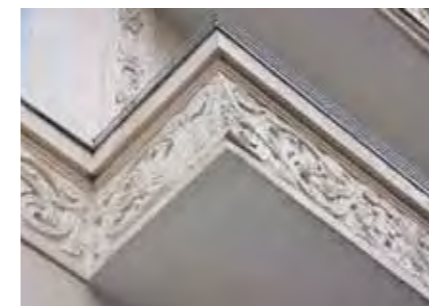
Massive Balkonbrüstung mit Jugendstilfassade
