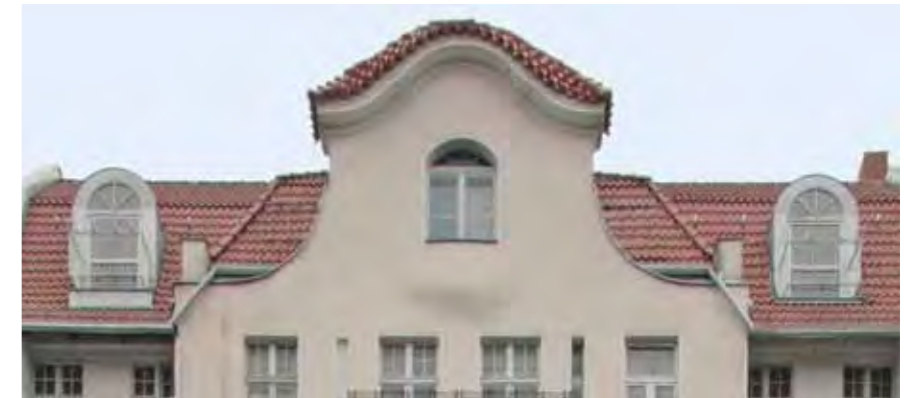
Neue Elemente ordnen sich der historischen Dachgestalt unter
