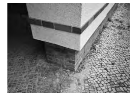
Aufdickung der Fassade, Verlust der Gliederung und Verkleinerung der Fensterformate durch Außendämmung mit Wärmedämmverbundsystem (Block 167, Oder-, Kienitzer- und Allerstraße)
