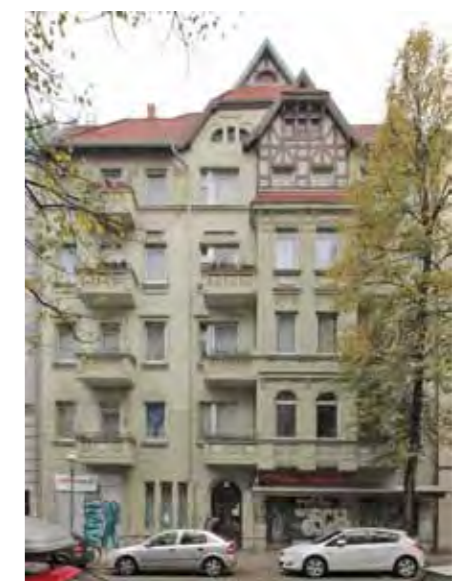
Haus im Heimatstil mit vorgeblendetem Fachwerkgiebel, Leinestraße 56
