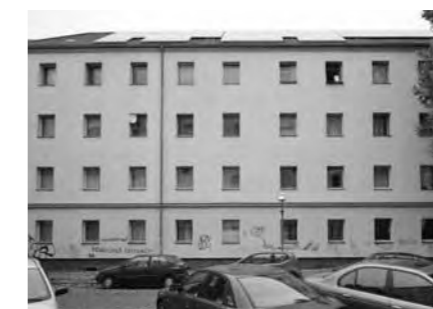
Aufdickung der Fassade, Verlust der Gliederung und Verkleinerung der Fensterformate durch Außendämmung mit Wärmedämmverbundsystem (Block 167, Oder-, Kienitzer- und Allerstraße)
