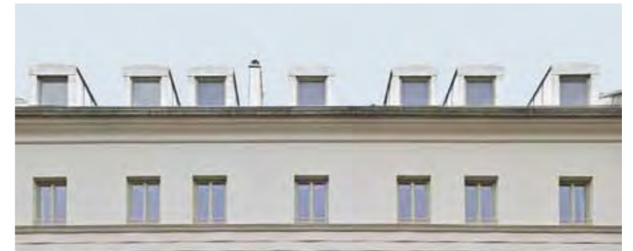
Dachgauben im Rhythmus der Fassadenfenster
