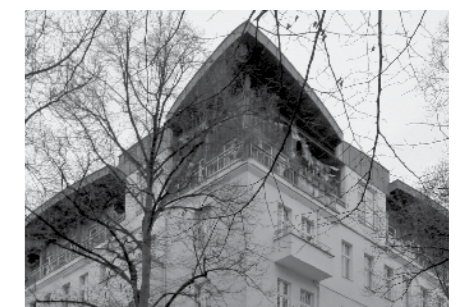
Verlust der ursprünglichen Dachform durch voluminöse Aufbauten
