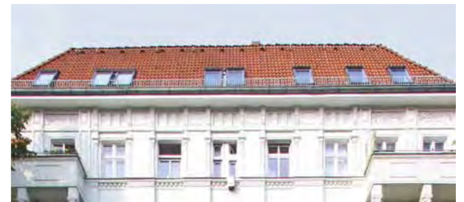
Dachflächenfenster lassen die Dachform unverändert, beeinträchtigen jedoch die geschlossene Erscheinung der Dachfläche.
