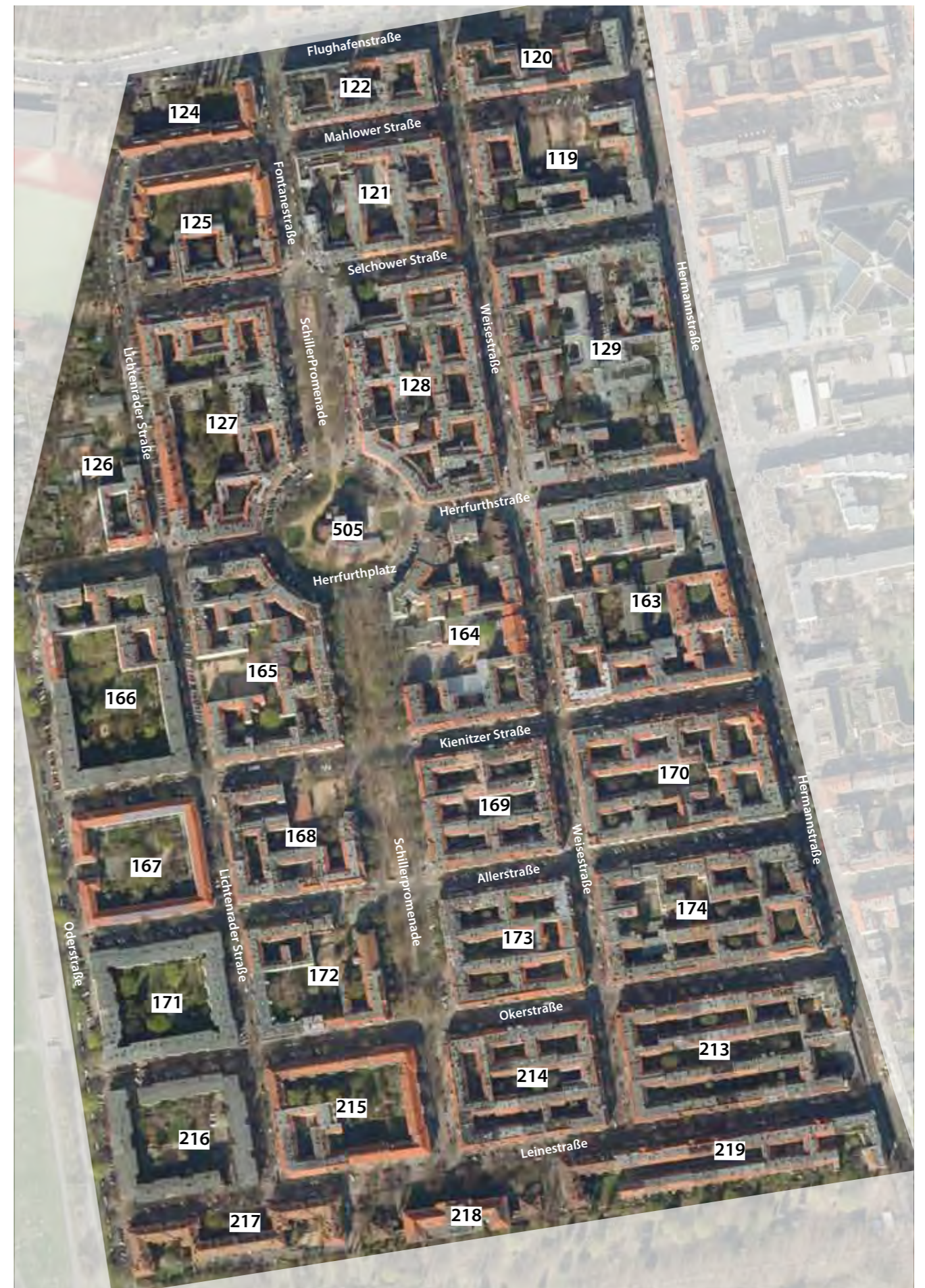
Luftaufnahme des Erhaltungsgebiets Schillerpromenade, Berlin-Neukölln, 2014
