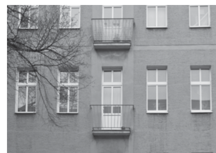
Entfernte Balkone (Französis. Fenster)
