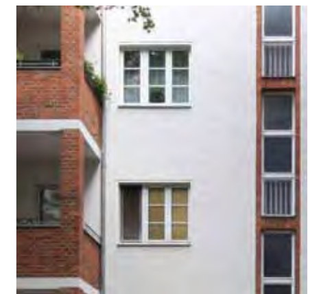
Rauputzfassade der Reformblöcke mit Klinkerelementen
