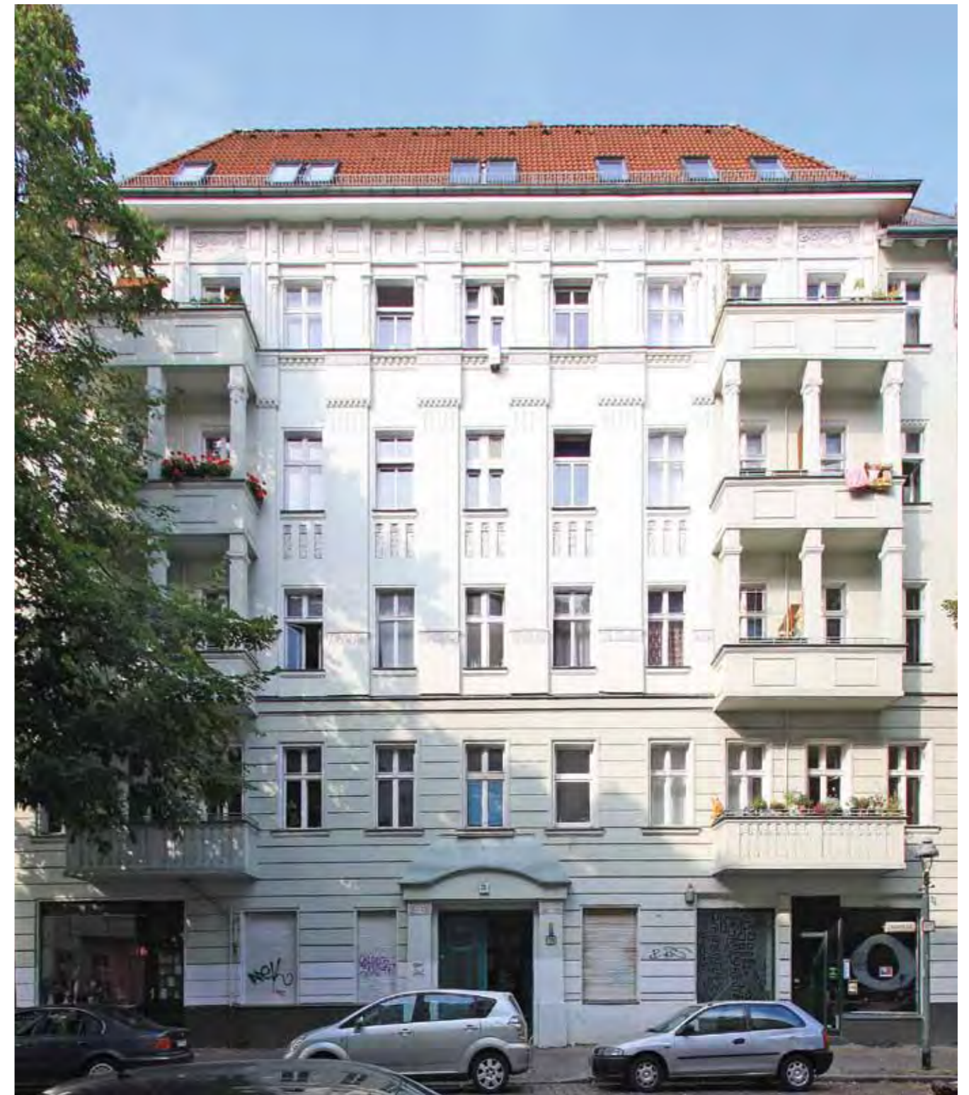
Sanierter Gründerzeitbau mit erhaltener Stuckfassade aus der Jugendstilzeit, Weisestraße 24
