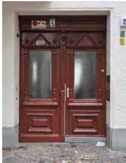
Neo-Renaissance Haustür mit bossierter Füllung unten und Säulenumrahmung der Verglasung. Verlust der ursprünglichen Sprossen.
