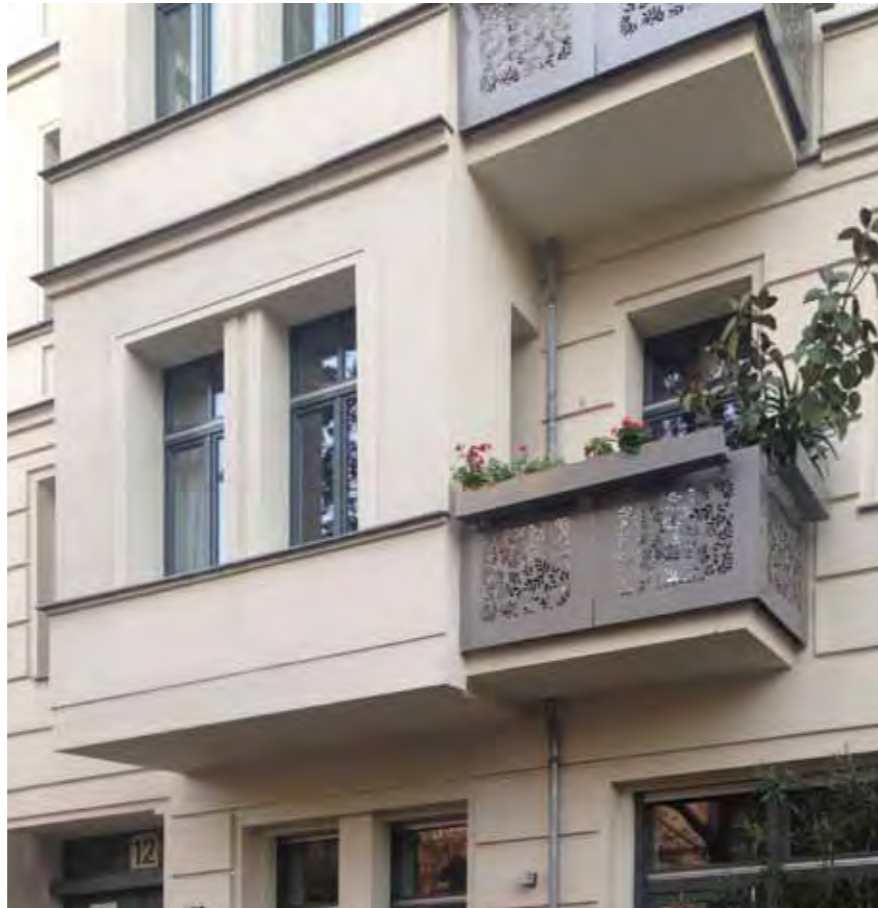
Neu gestaltete Fassadengliederung einer ehemals entstickten Fassade
