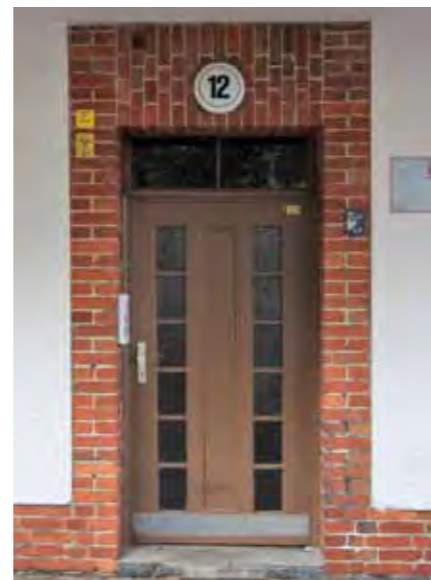
Haustür eines Reformwohnungsbaus mit Klinkereinfassung (einflügelig)
